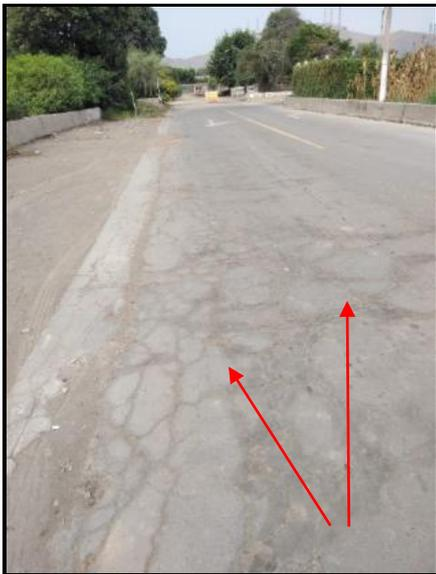
**Figura N° 40:** Falla en pavimentos asfálticos (piel de cocodrilo) al interior del campus.
