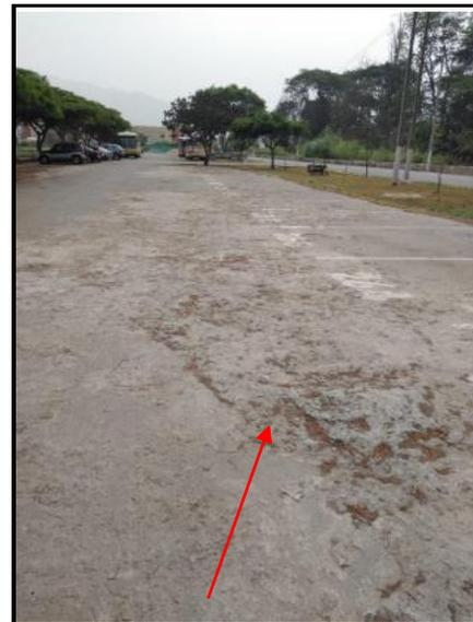
**Figura N° 41:** Falla en pavimentos asfálticos (agrietamientos) al interior del campus.
