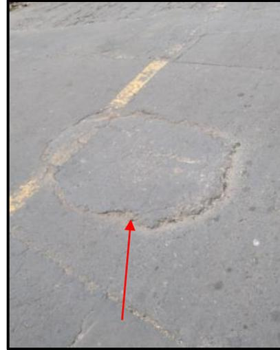
**Figura N° 39:** Falla en pavimentos asfálticos (desprendimiento de material en las juntas asfálticas originadas por trabajos de recapados), al interior del campus.
