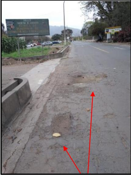
**Figura N° 38:** Falla en pavimentos asfálticos (Peladuras y desprendimiento de material), de la “Sub-zona 3”.
