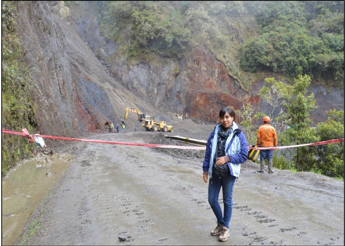
Figura 39: Derrumbes en la temporada de lluvias
