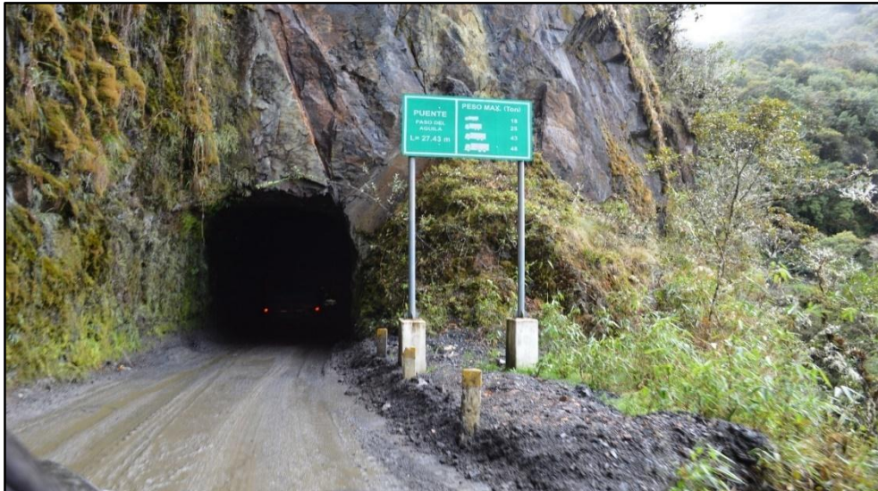
Figura 57: Túnel que conecta la provincia de Paucartambo con el Distrito de Kosñipata
