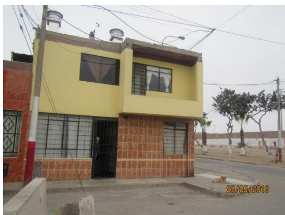
Punto de monitoreo ubicado en el PP.JJ. Ramón Castilla "Block K-21".
