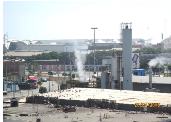
Actividad industrial en Av. Alfredo Palacios, cerca de E-07.
