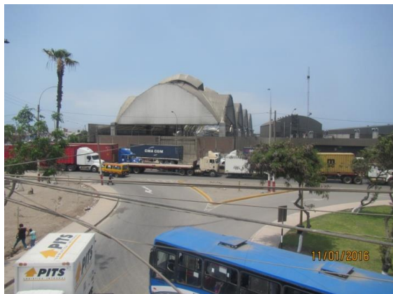
Tráfico vehicular en Av. Néstor Gambeta frente a la estación E-04A.
