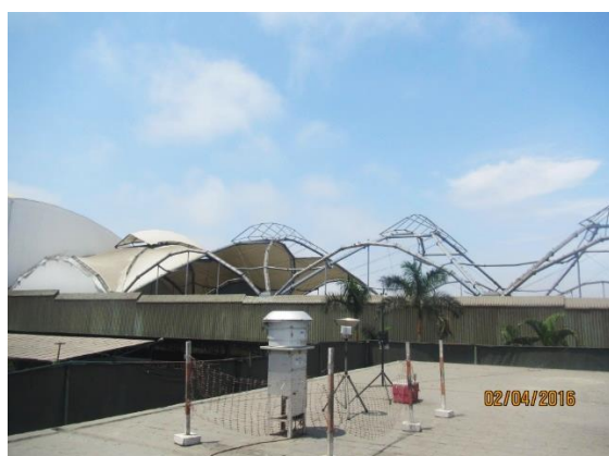
Depósitos de minerales parcialmente techados.
