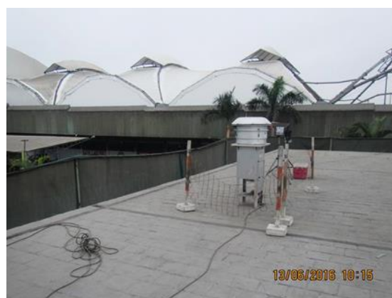
Depósitos de minerales parcialmente techados.
