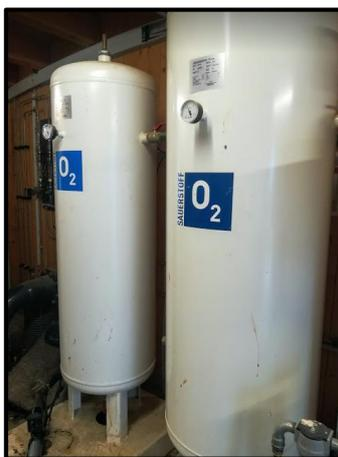
**Figura 3. Sistema de aireación usado en planta de biogás en Stuttgart, Alemania.**
