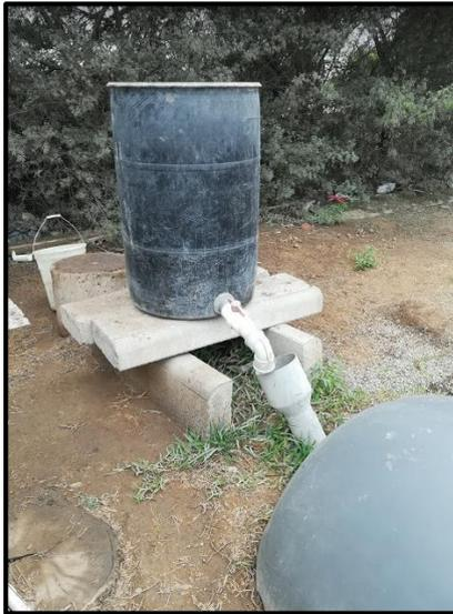
**Fotografía 3. Cargado del biodigestor tubular.**
