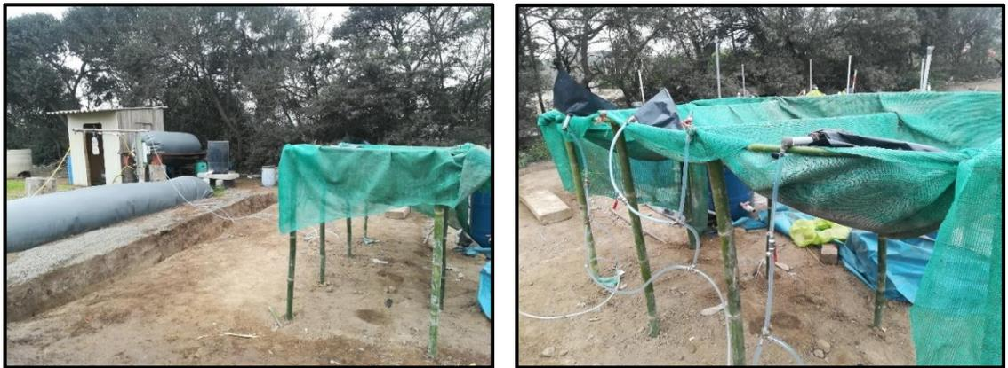
**Fotografía 17. Bolsas para almacenamiento de biogás unidas al biodigestor.**
