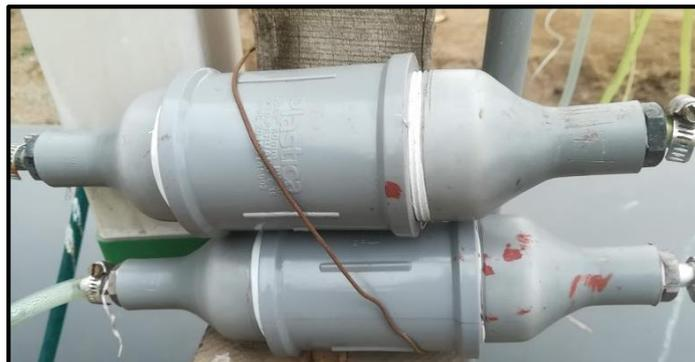
**Fotografía 16. Filtros de sulfuro de hidrógeno instalado en biodigestor.**
