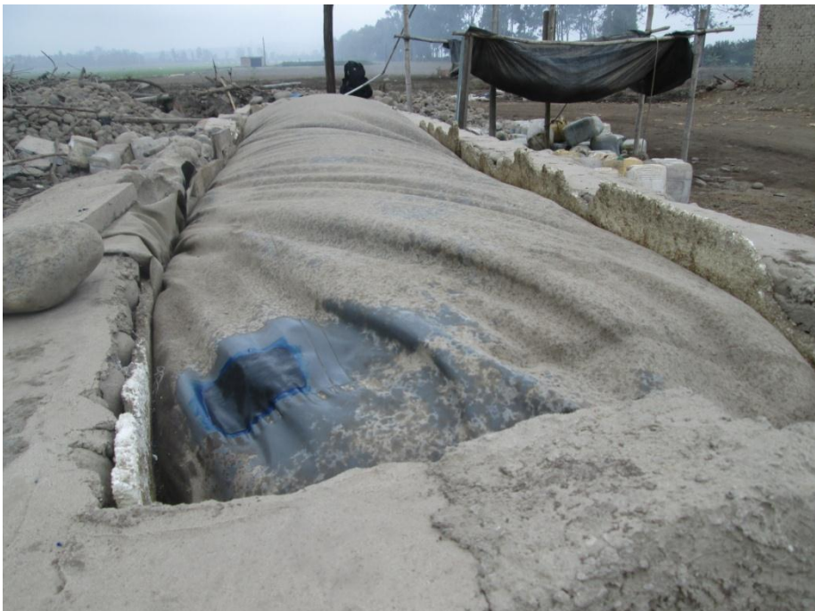
Fotografía 4: Restauración de la Geomenbrana del biodigestor
