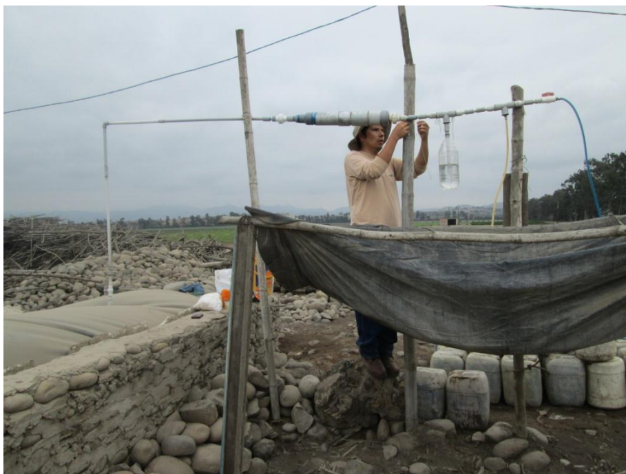
Fotografía 5: Reparación de las tuberías de Biogás
