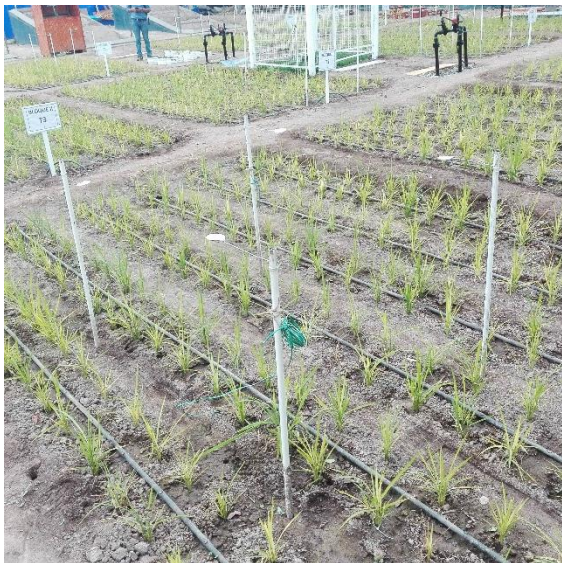
Instalación de barras de acero con círculos de aluminio en cada parcela.
