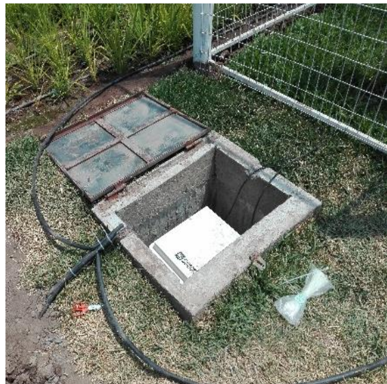
Acondicionamiento final mediante la colocación de cintas de ajuste y mangueras enterradas.
