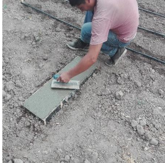
Construcción y nivelación de bloques de concreto en cada parcela.
