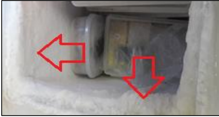
Figura 10: Equipo con escarcha.
