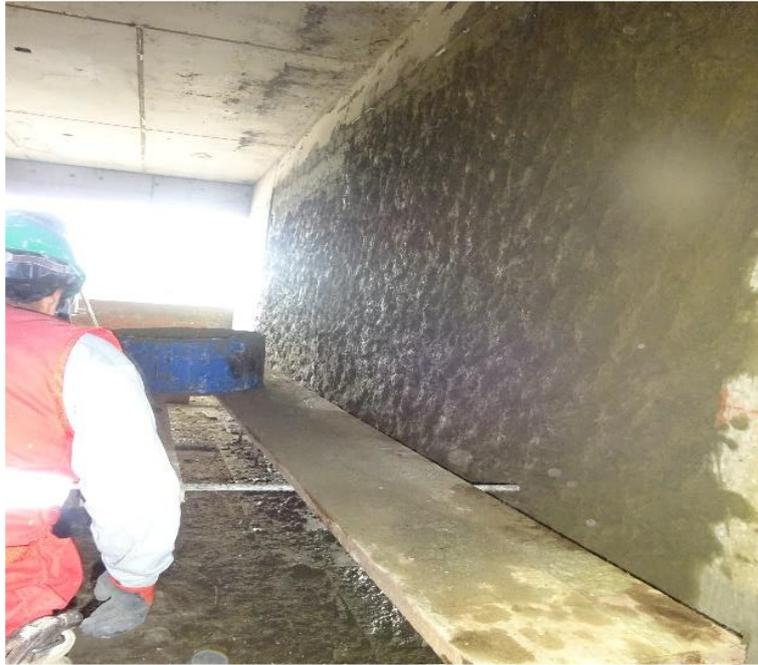
**Figura 24. Tarrajeo de muro interior en los ambientes de obra.**
