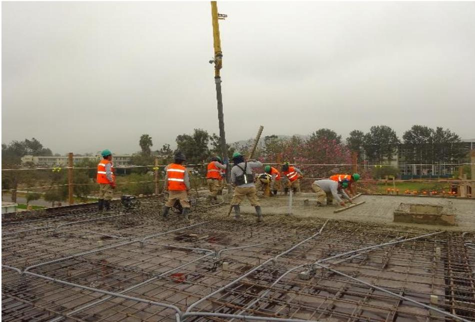
**Figura 22. Vaciado de segundo techo con concreto premezclado.**
