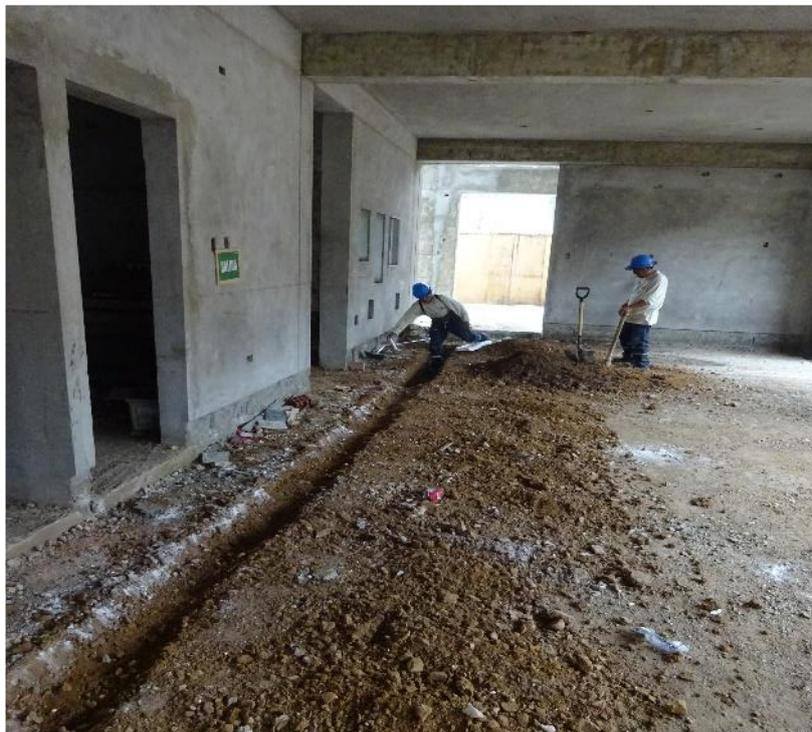
**Figura 30. Excavación de instalaciones interiores A.C.I.**
