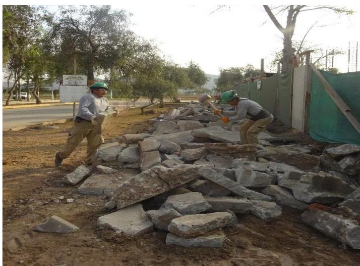
**Figura 12. Rotura de vereda en mal estado en la parte frontal de la obra.**
