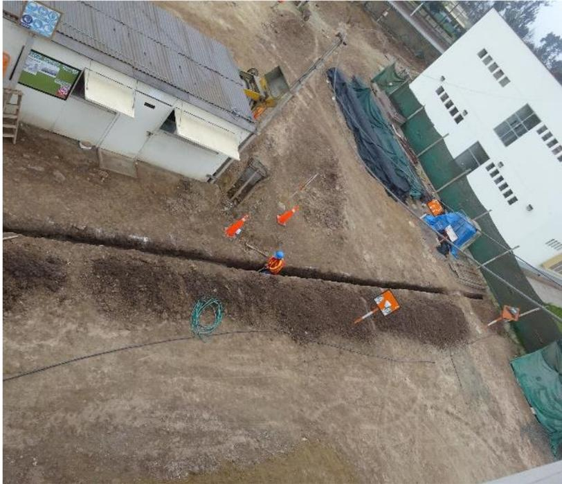
**Figura 29. Excavación de instalaciones exteriores del A.C.I**
