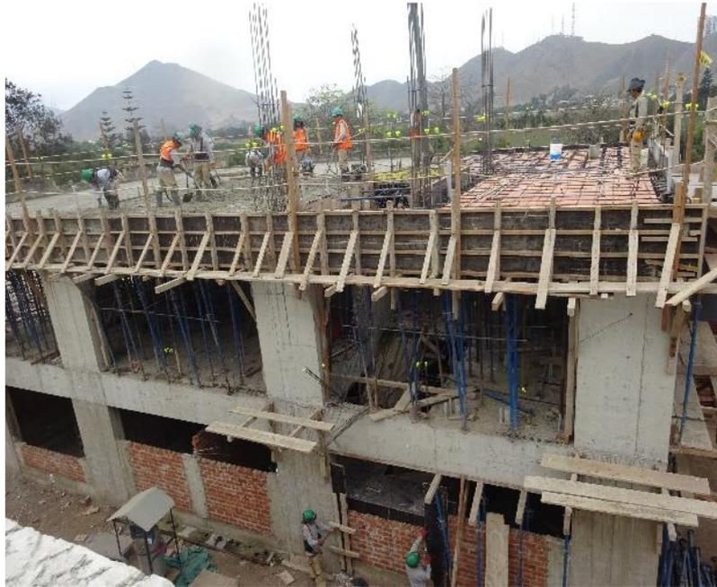
**Figura 26. Vaciado de losa de techo en segundo piso de laboratorios.**
