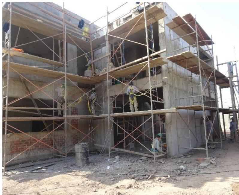
**Figura 27. Tarrajeo de muro exterior en primer y segundo piso.**
