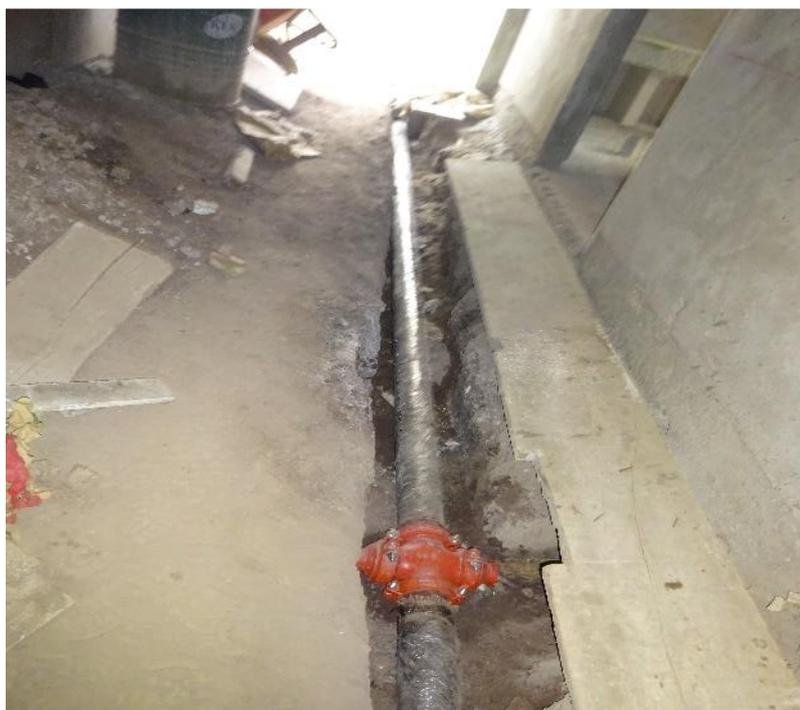
**Figura 31. Colocación de tuberías A.C.I sin cama de arena.**
