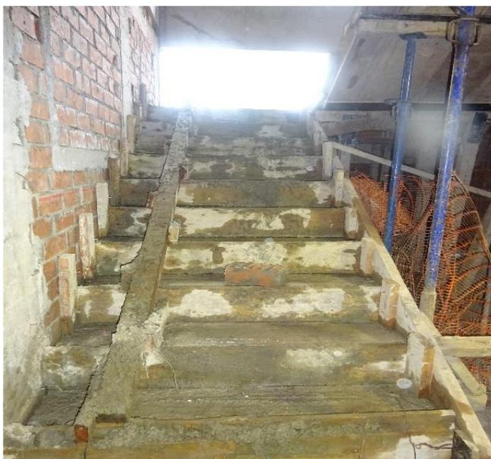
**Figura 21. Vaciado con concreto para para escaleras interiores.**
