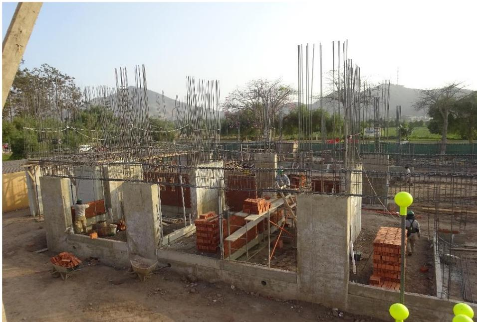
**Figura 20. Conformidad técnica de placas y armado de vigas de techo.**
