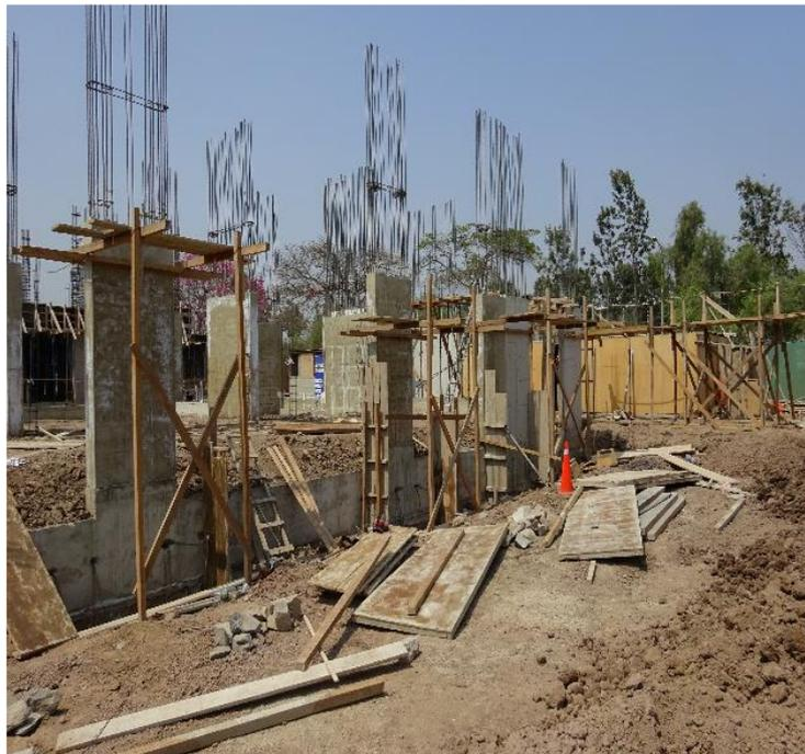
**Figura 16. Encofrado de columnas y placas abandonado por paralización municipal.**
