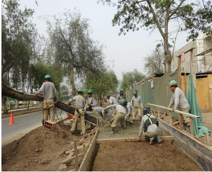
**Figura 13. Vaciado de vereda que se encontraba en mal estado.**
