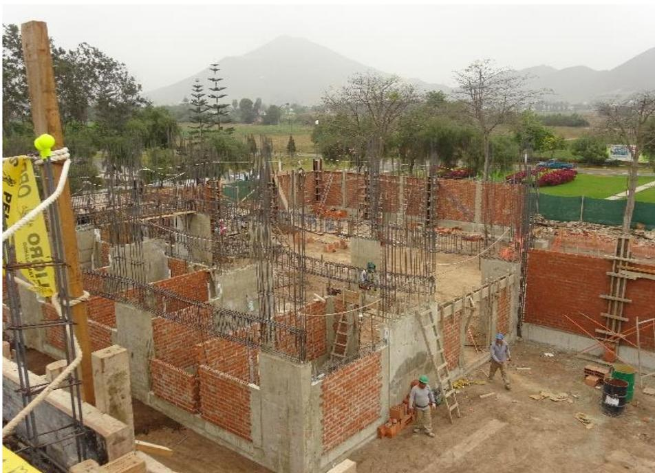
**Figura 23. Asentado de ladrillos para muros.**
