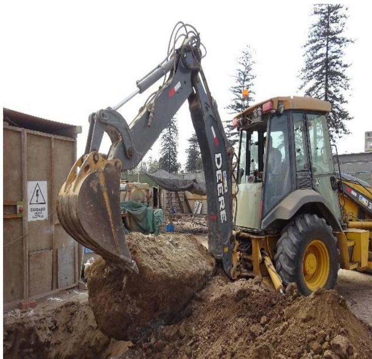
**Figura 14. Utilización de la retroexcavadora para retirar concreto encontrado.**
