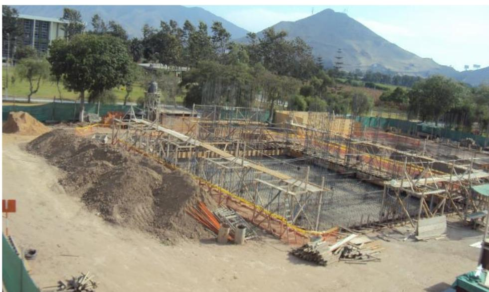
**Figura 18. Preparación de platea de cimentación para vaciado con concreto.**
