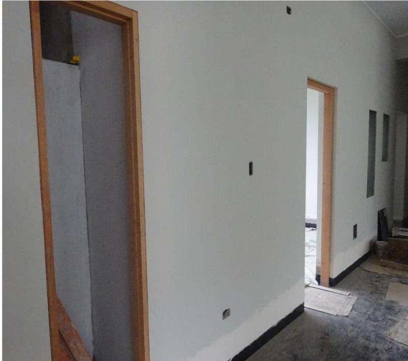
**Figura 32. Instalación de marcos de puertas de veredas.**
