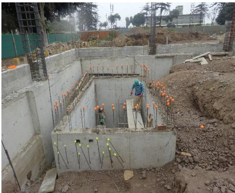
**Figura 25. Vaciado de piso y muro de cisterna.**
