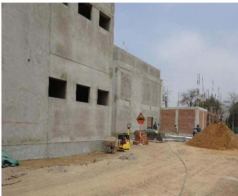
**Figura 28. Compactación de terreno alrededor de los edificios para veredas.**
