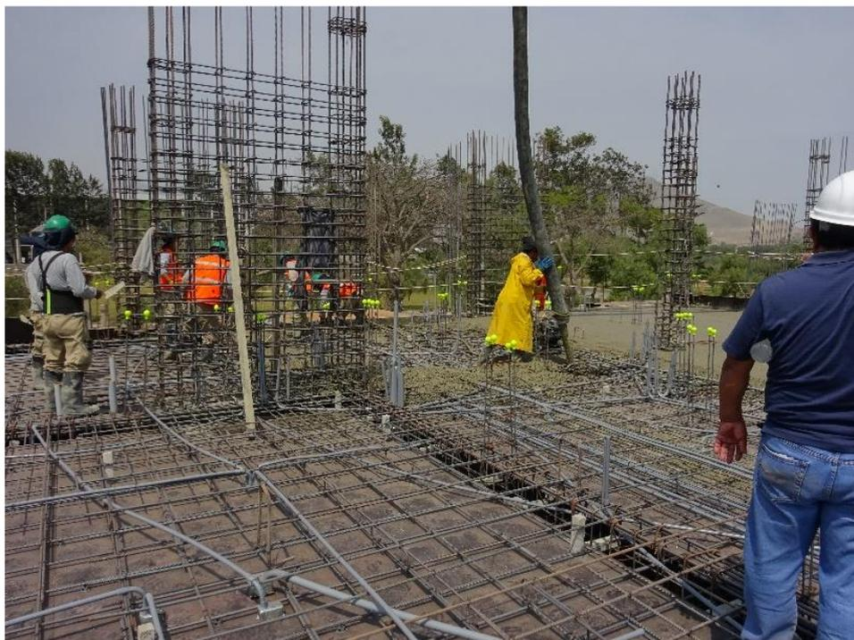
**Figura 19. Vaciado de losa maciza con concreto premezclado.**
