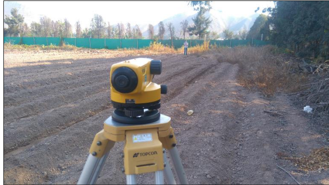
Figura 24: Levantamiento de cotas con el nivel de ingeniero.
