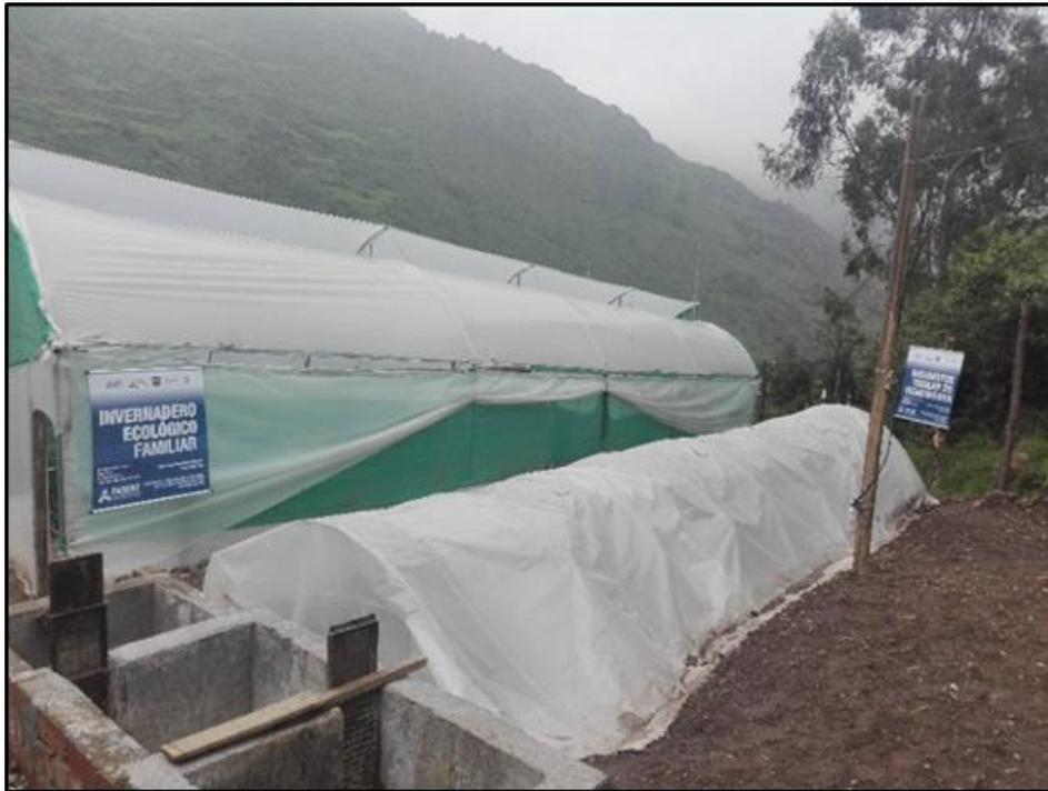
**Figura 7: Biodigestor tubular instalado en el anexo de Soca – Matucana**
