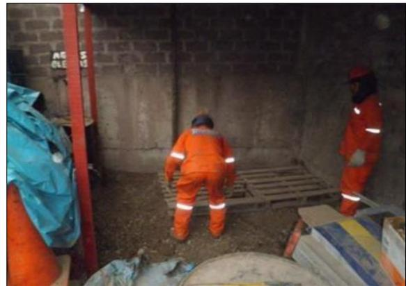
**Fotografías 27 y 28: Cobertura con 10 cm. de capa de tierra y colocación de parihuelas**
