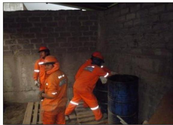
**Fotografías 29 y 30: Traslado de contenedores de residuos peligrosos (aceites usados y aguas oleosas) a zona impermeabilizada y techada**
