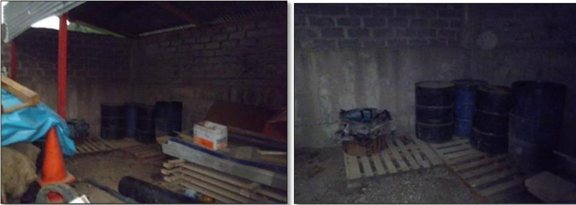
**Fotos 31 y 32: Contenedores de residuos peligrosos (aguas oleosas y aceites usados) dispuestos correctamente en zona impermeabilizada y techada**
