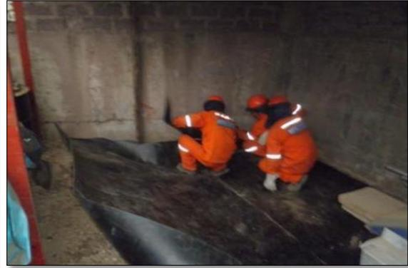
**Fotografías 25 y 26: Impermeabilización del suelo con Geomembrana**
