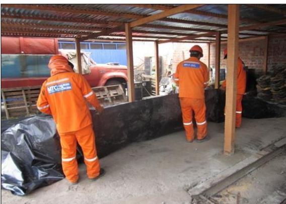
Fotografías 3 y 4: Impermeabilización de patio de residuos
