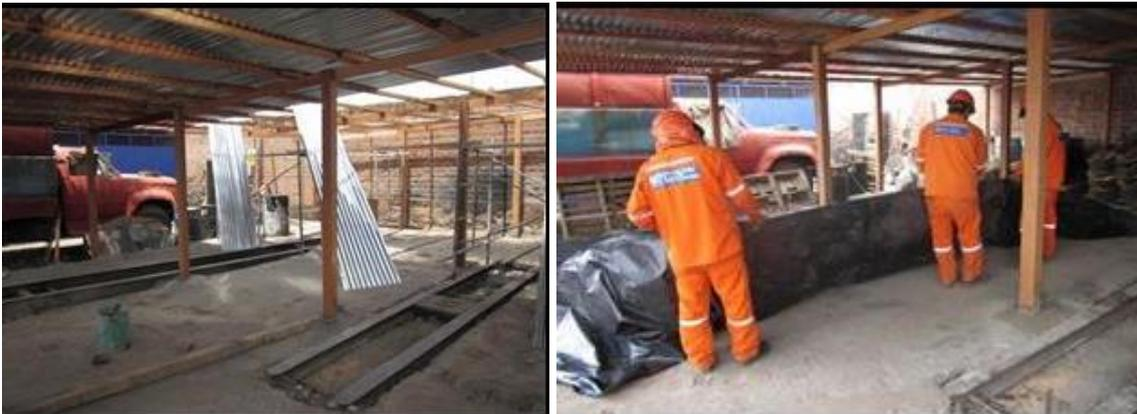
**Fotografías 3 y 4: Impermeabilización de patio de residuos**
