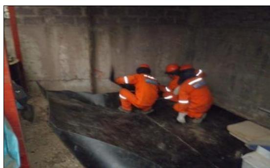
**Fotografías 25 y 26: Impermeabilización del suelo con Geomembrana**
