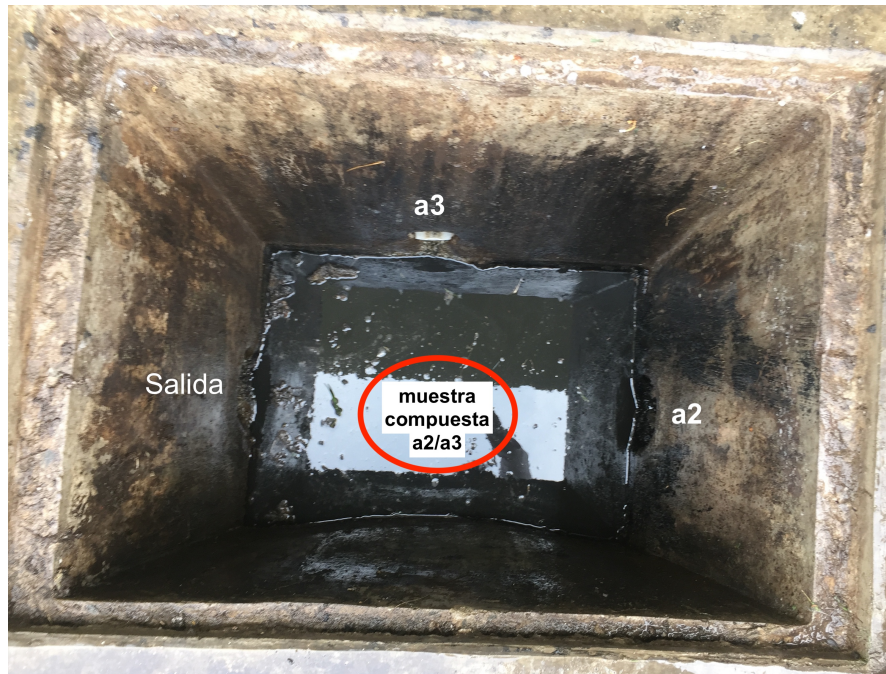
Figura 7: Buzón de alcantarilla (punto a2 y a3) e ilustración de método de muestreo.
