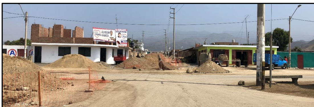
Figura 40: Material de construcción al costado de la carretera a Lomas de Asia.
