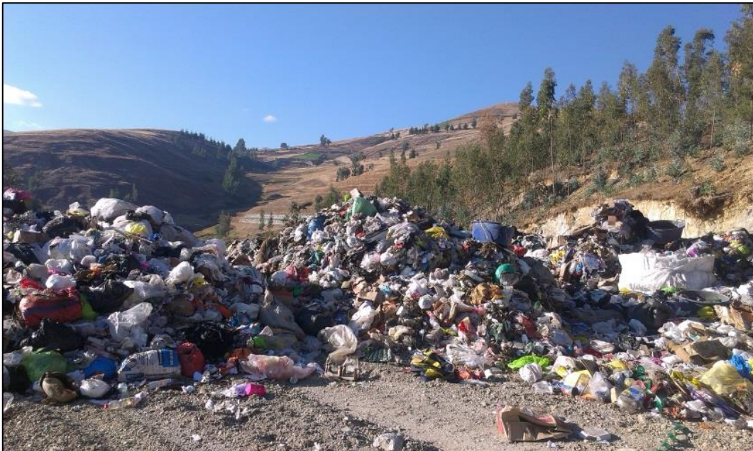
Fotografía 5: Sin conformación de celdas
