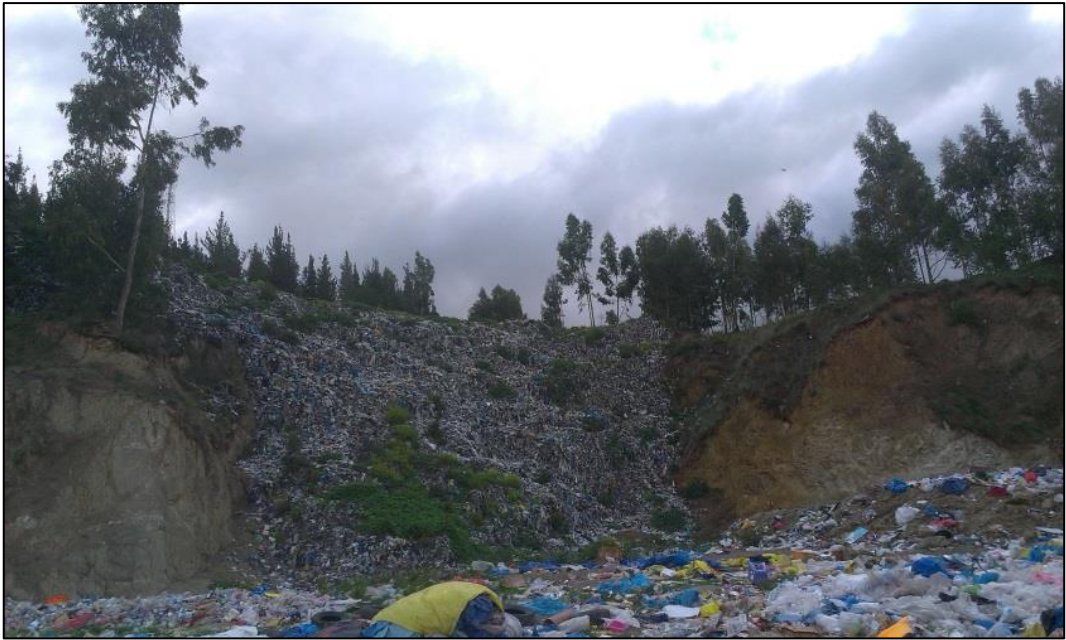
Fotografía 1: Plataforma abandonada sin cobertura
