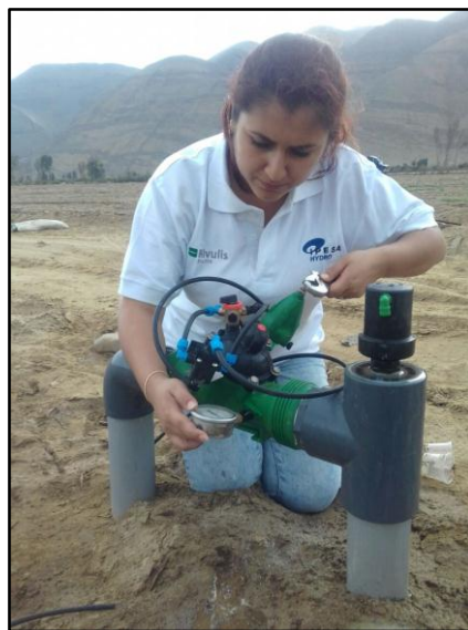
Figura 10. Calibración de válvula
