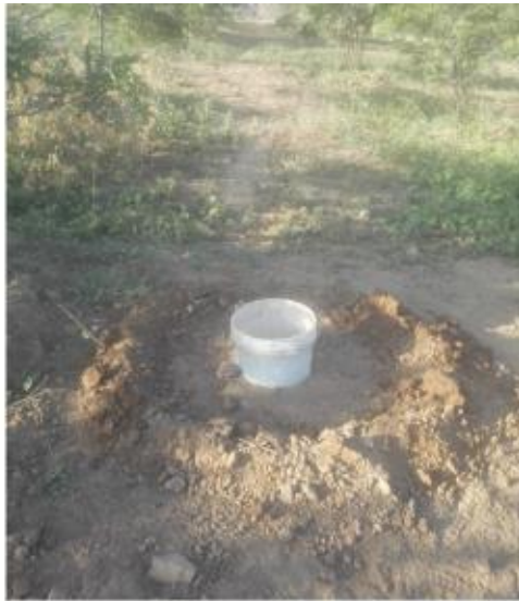
a. Instalación de balde para prueba
