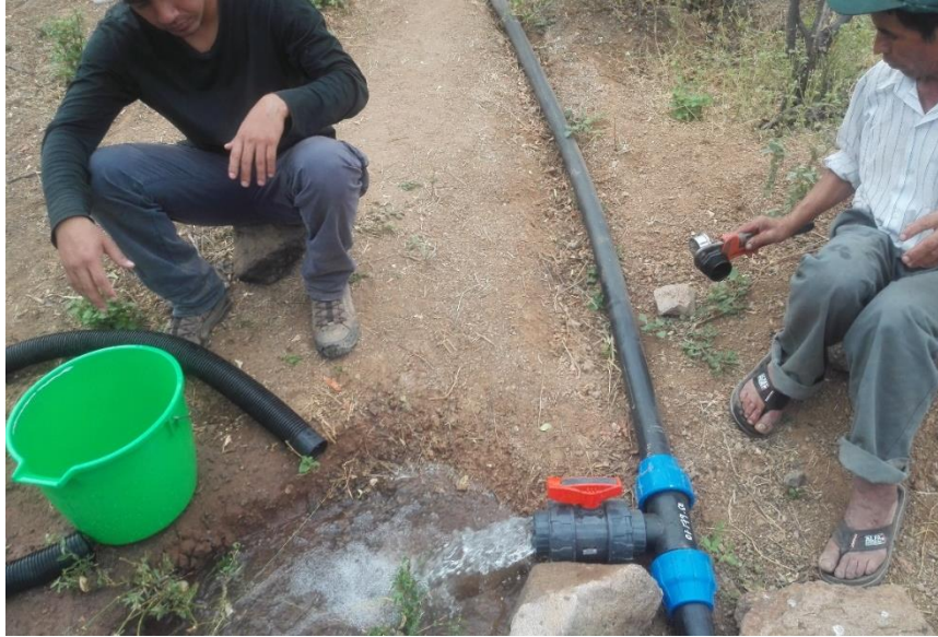
Figura 29: Aforo volumétrico en las válvulas
