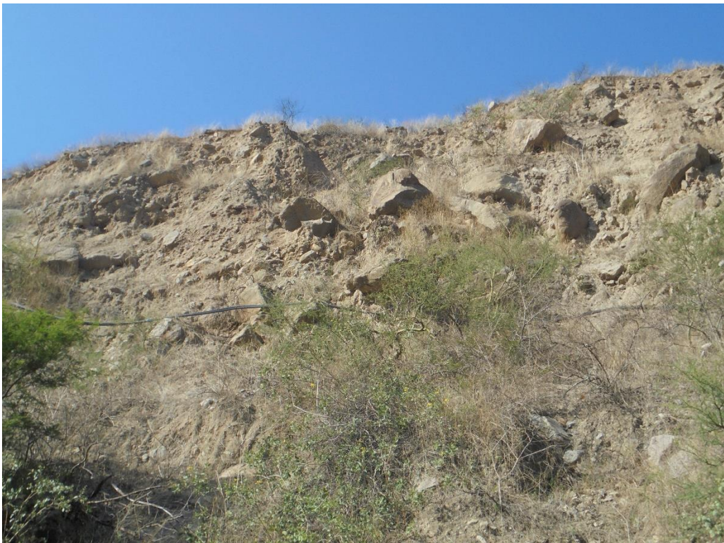
Figura 43: Tubería de conducción en peñascos km 1.8
