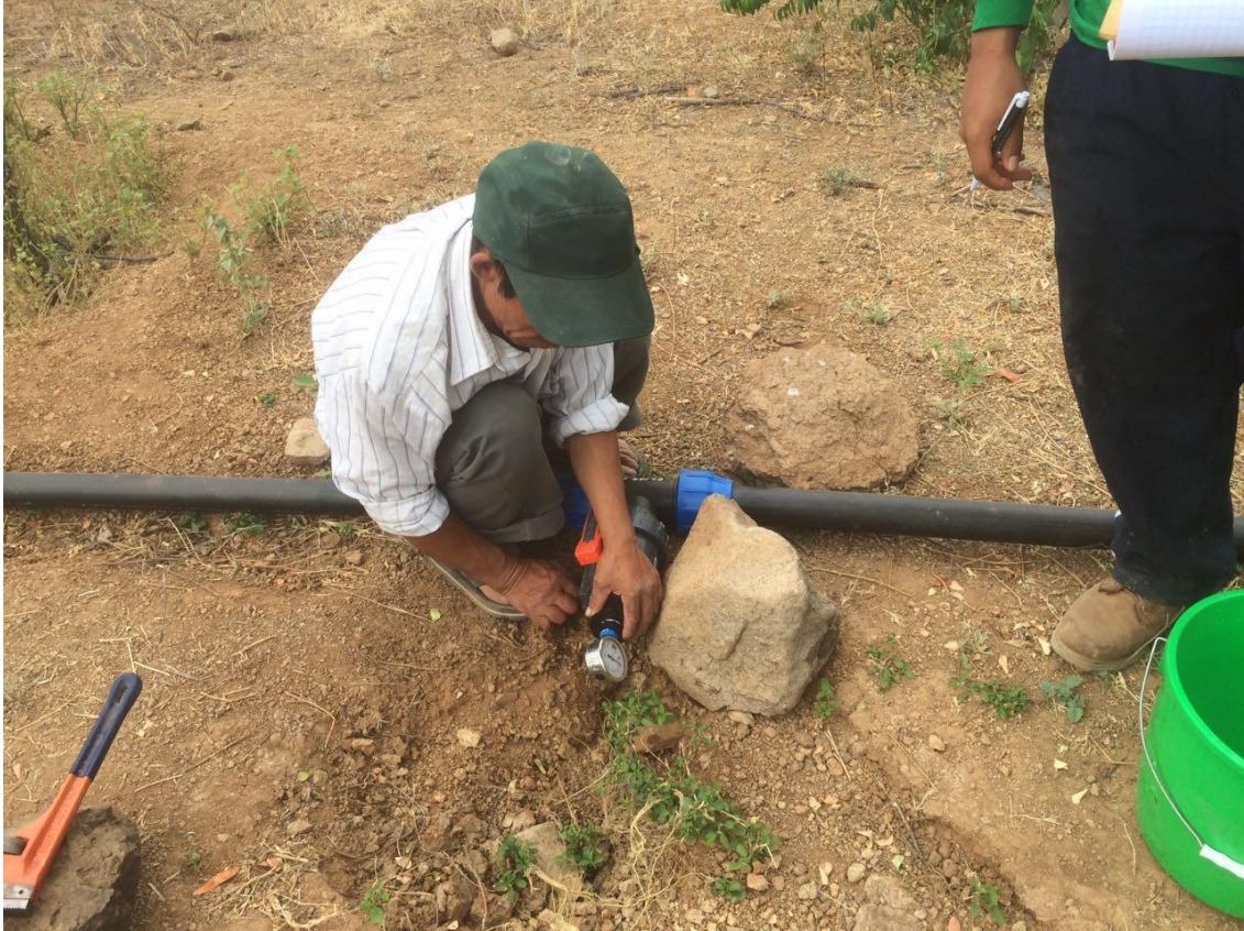
Figura 46: Prueba de presión en válvula
