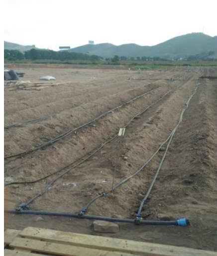
Instalaciones de cintas de riego
