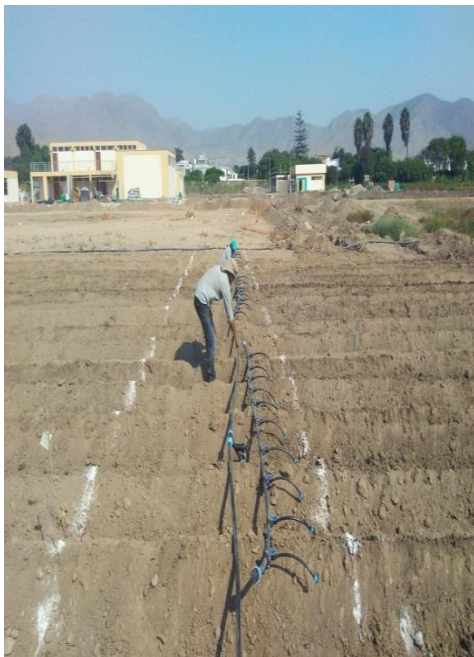
Instalaciones de tubería tercería
