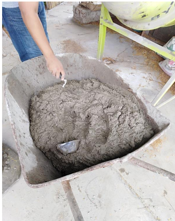
Figura 49: Vertido de concreto liviano de mezcla homogénea
