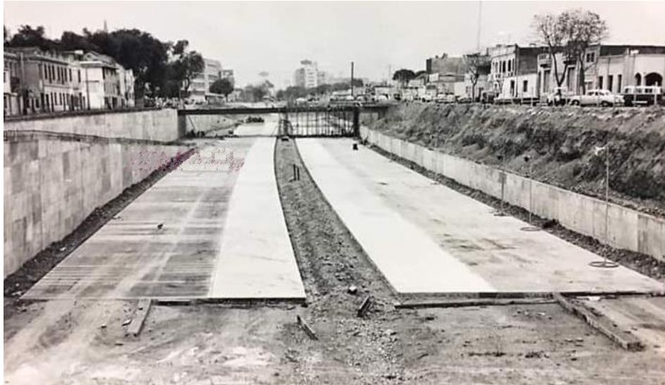
Figura 1: Pavimentación con concreto en la vía expresa de Lima (1966)
