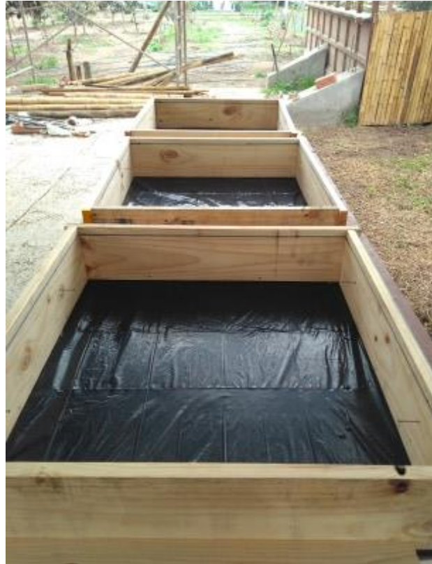
Figura 60: Preparación del encofrado de paneles de concreto liviano
