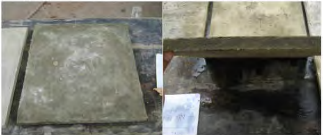
Figura 14. Tablero recién desmoldado (Foto: A. Espinoza)
