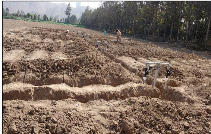
Colocación de tuberías
