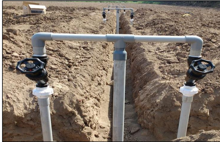
Colocación de los arcos de riego
