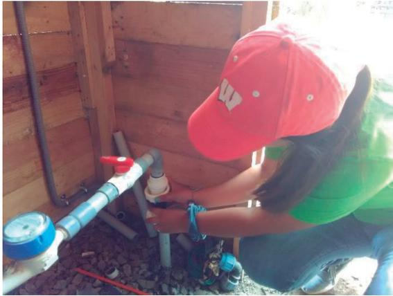
**Figura 140: Instalación del sensor de caudal**
