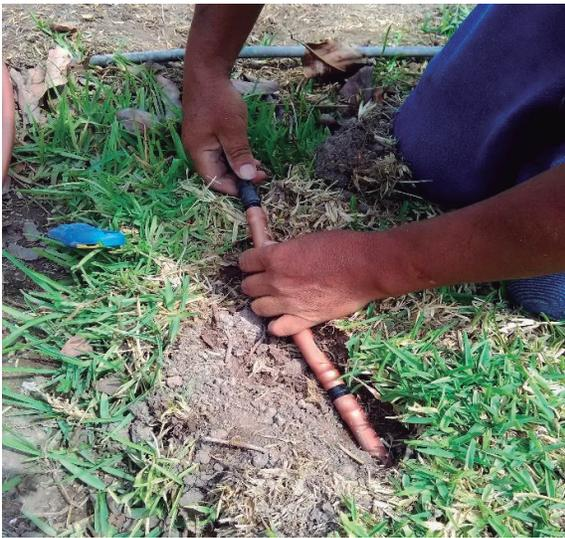
**Figura 125: Reparación de manguera subterránea**
