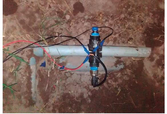
**Figura 139: instalación del sensor de presión**
