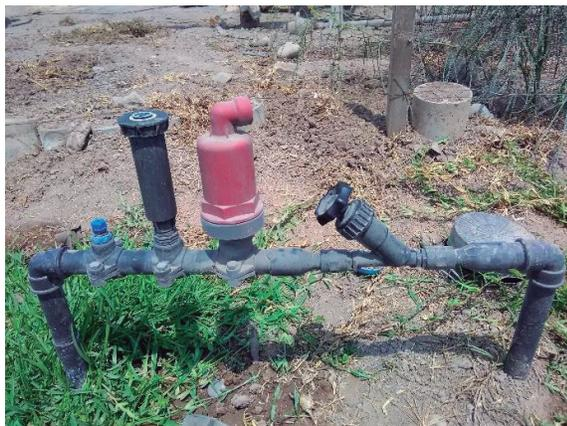
**Figura 121: Arco de riego manual**
