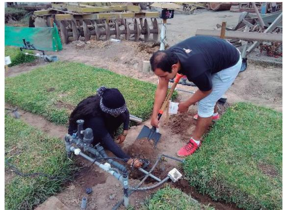
**Figura 142: Instalación de sensor de humedad**
