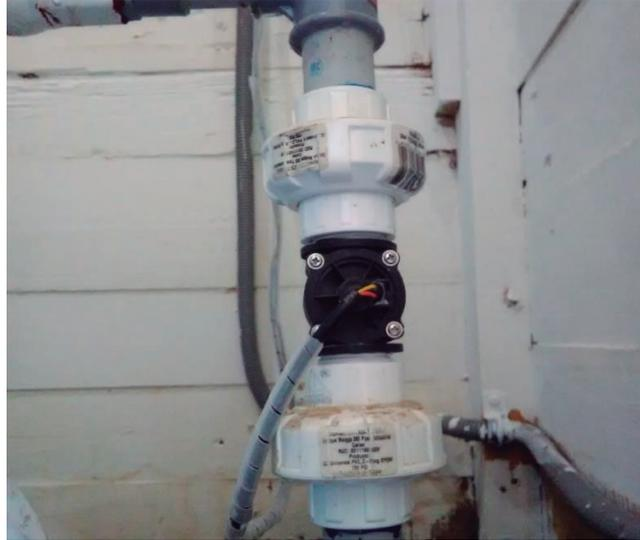
**Figura 27: Sensor de caudal FS400 al final del cabezal**
