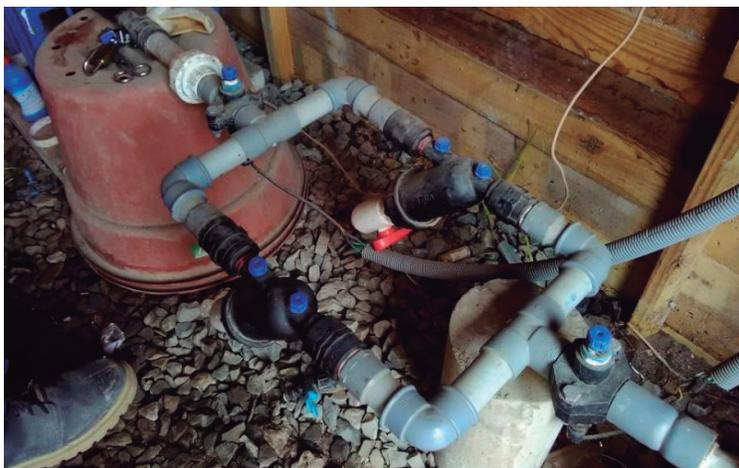
**Figura 26: Sensores de presión antes y después de los filtros**
