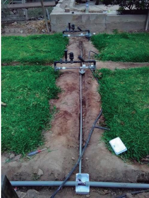
**Figura 135: Instalación de tubería de luz y cajas de pase**
