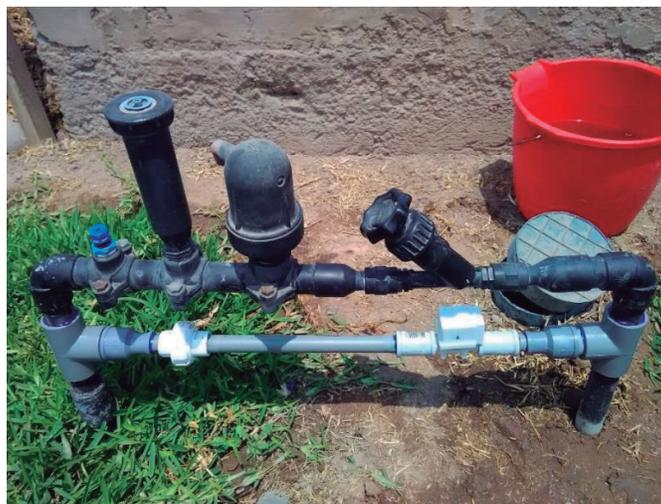
**Figura 28: Arco de riego de apertura manual y automática**
