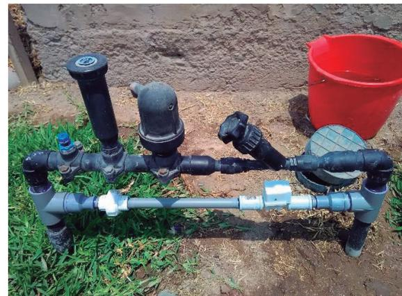
**Figura 122: Arco de riego manual y automatizado**
