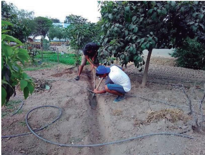
**Figura 133: Zanjeado para colocar tubería de luz**
