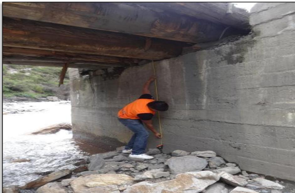
**Figura 45: Vista fotográfica de la marca de agua máxima en el estribó izquierdo del puente actual Runichinchay**
