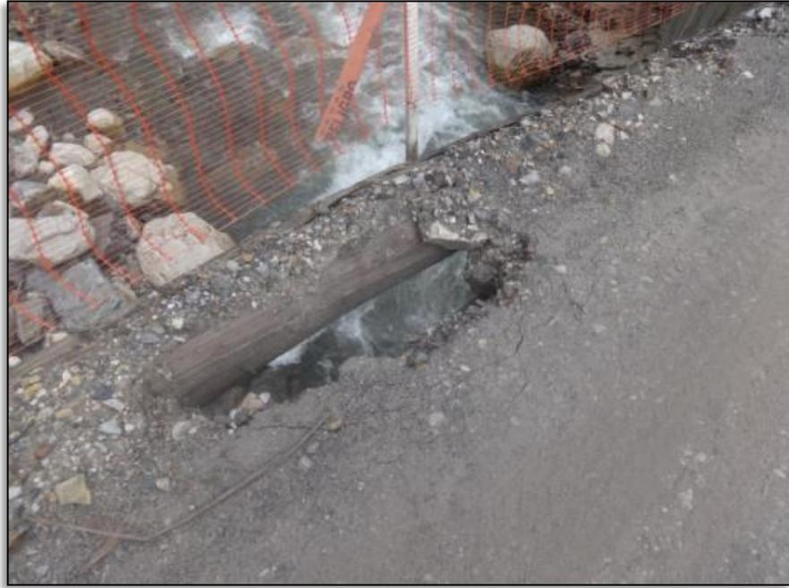
**Figura 113: Mal estado de la plataforma del puente actual existente**
