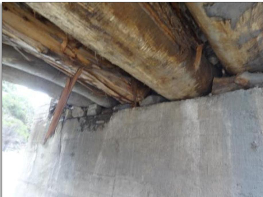
**Figura 110: Rollizos de madera en la superestructura con estado de putrefacción**
