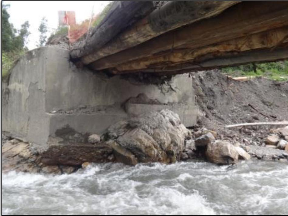
**Figura 111: Estribo derecho con proceso de erosión**
