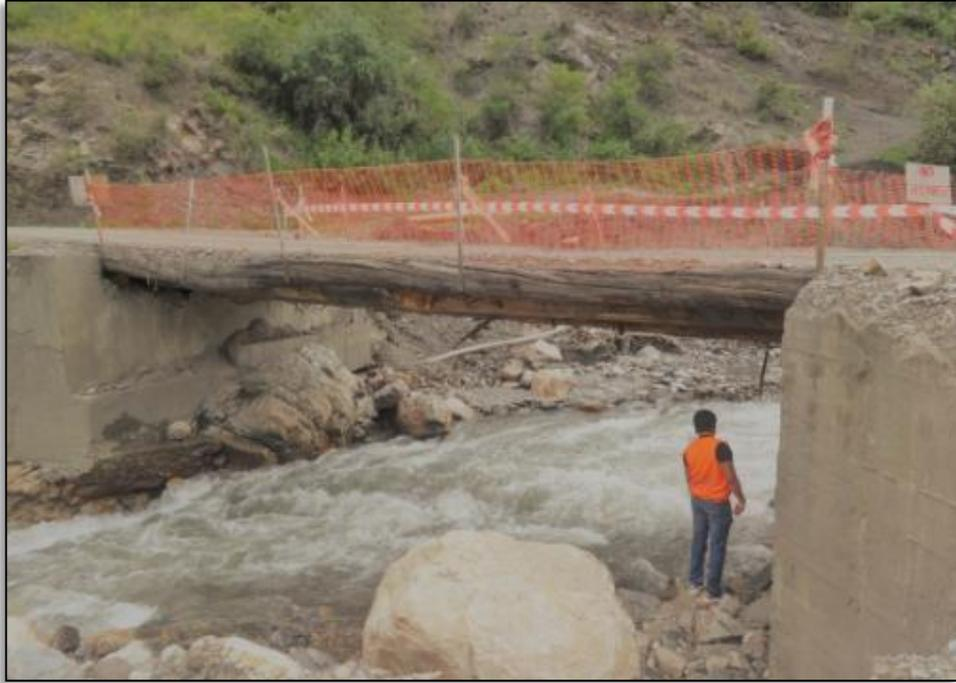
**Figura 109: Determinación de la marca de agua máxima en estribo del puente actual existente**
