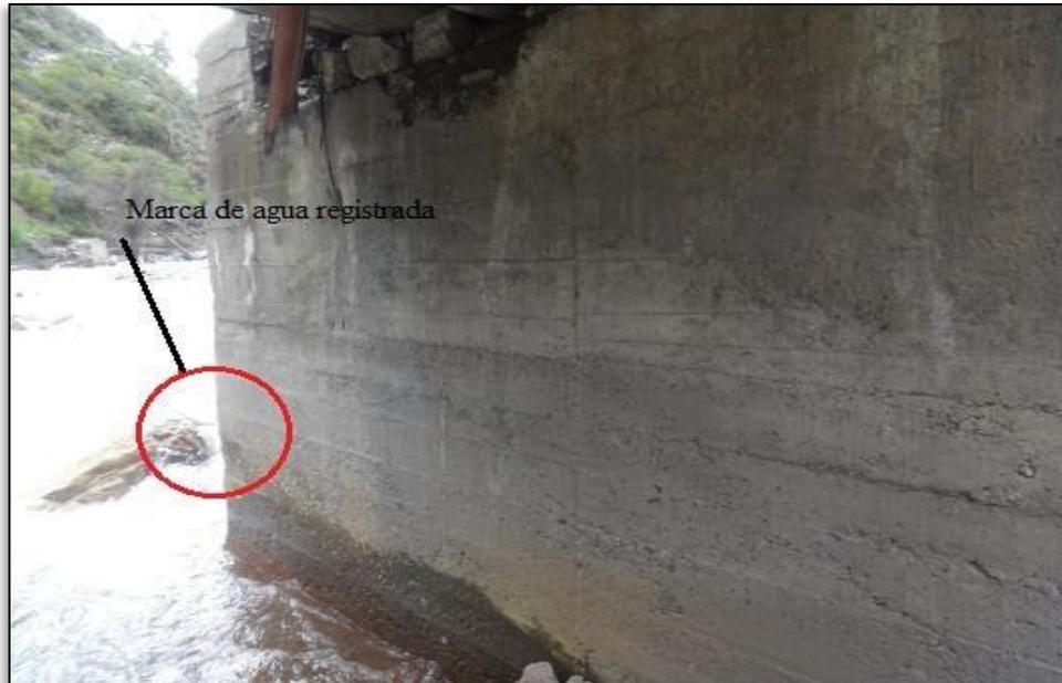
**Figura 44: Vista fotográfica de la marca de agua máxima en el estribó izquierdo del puente actual Runichinchay**
