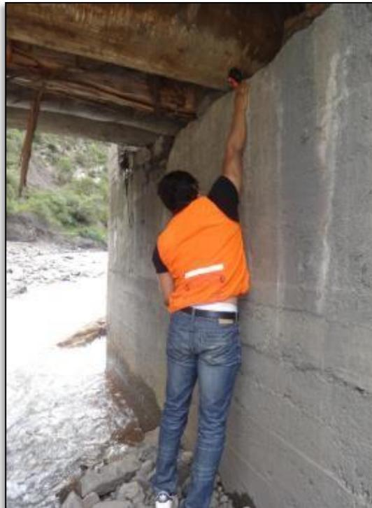
**Figura 112: Estribo izquierdo para el registro del nivel de agua máximo**
