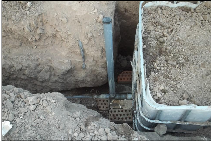
Figura 16: Conexión del desfogue y alivio
