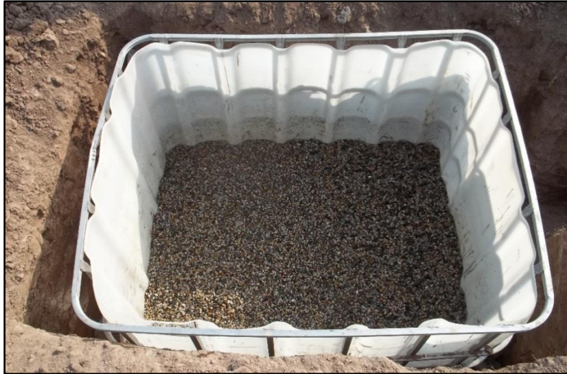
Figura 15: Uso de grava como material filtrante
