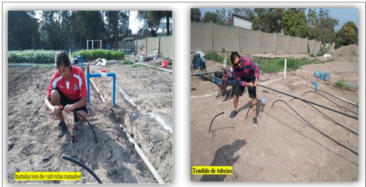
Figura 21: Instalación de accesorios
