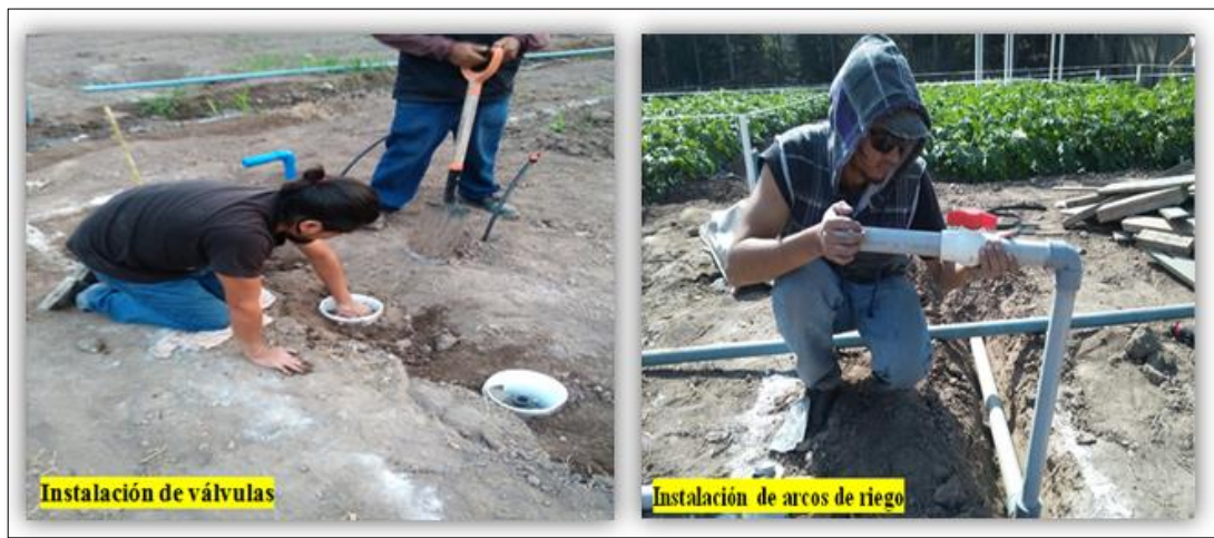
Figura 19: Instalación de arcos de riego
