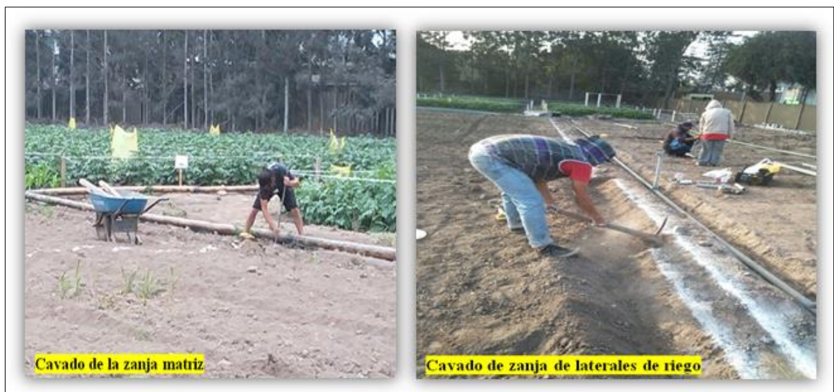
Figura 18: Excavación de zanjas
