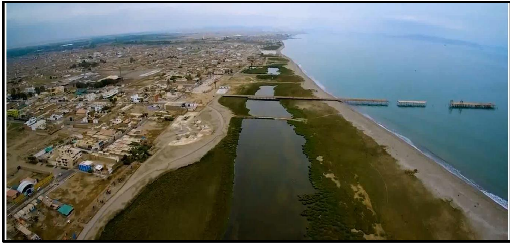
Vista Horizontal del humedal de Pisco
