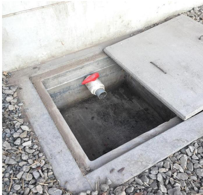
**Figura 12: Caja de Extracción de lodos**
