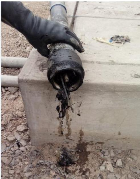
**Figura 25: Residuos atascados en la válvula check**
