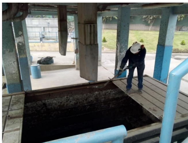
Figura 21: Toma de muestra en la centrífuga de la PTAR Santa Clara
