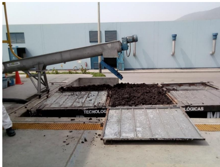
Figura 16: Lodos centrifugados de la PTAR Manchay
