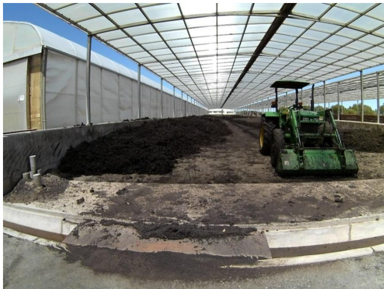
Figura 23: Lechos de secado de la PTAR La Escalerilla
