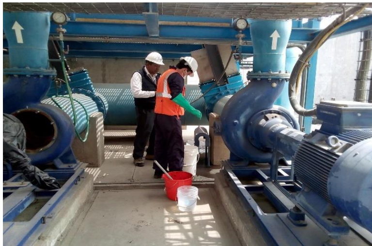
Figura 19: Toma de muestra de la manguera de purga del clarificador de la PTAR Santa Clara
