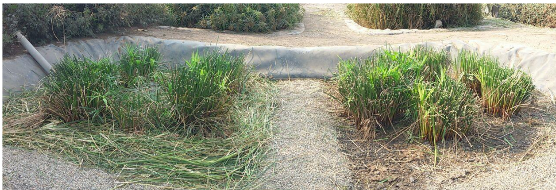
Figura 8: 1 ra etapa del Sistema Francés. Izquierda: línea cubierta con material orgánico adicional (aserrín + restos de vegetación; derecha: línea sin material orgánico adicional
