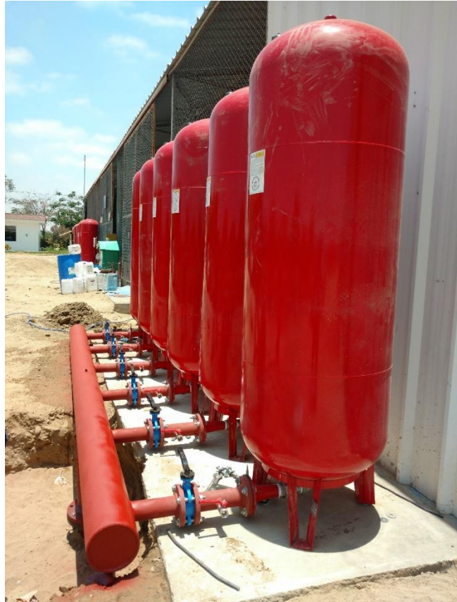
Figura 12: Tanques hidroneumáticos 1000 litros Proyecto 9715 Rapel impulsión 3 R4R5 (2017)
