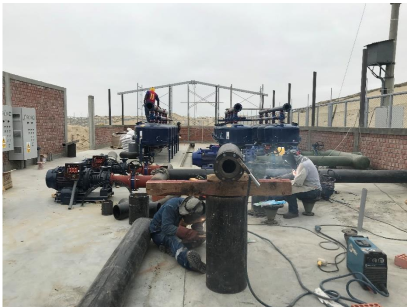
Figura 43: Proceso de soldado de manifold de acero
