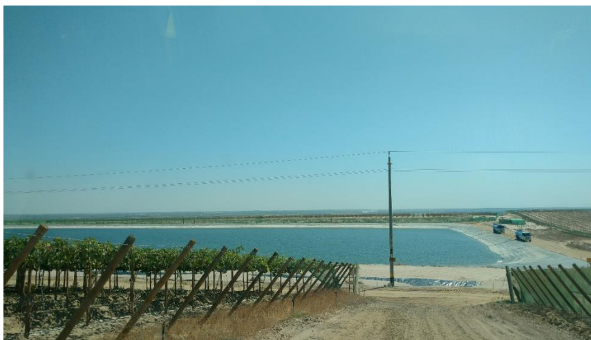
Figura 14: Reservorio de almacenamiento de 300 000 metros cúbicos Proyecto 9579 Reservorio R6
