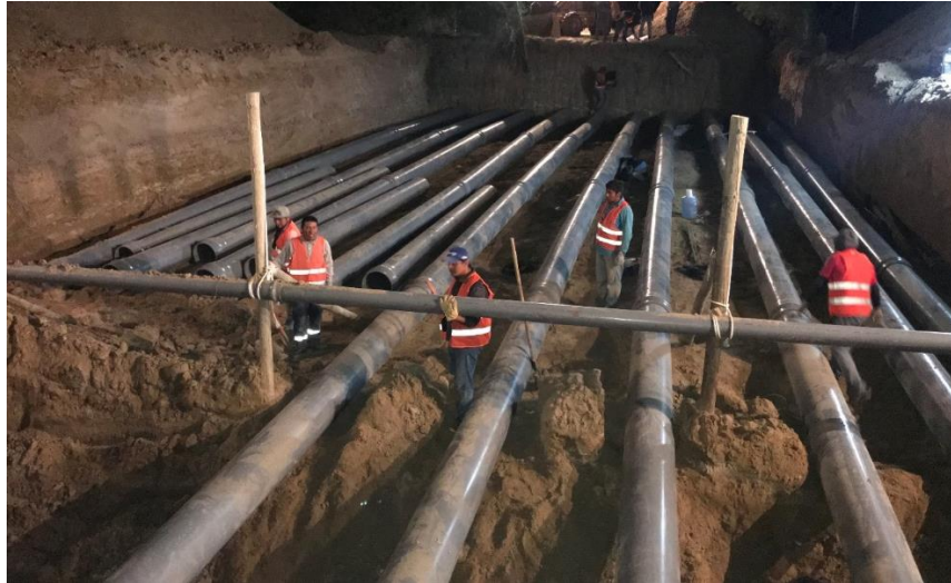
Figura 13: Instalación de aducciones de 400 mm Proyecto 9714 Impulsión R1R8 Etapa 1 (2017)
