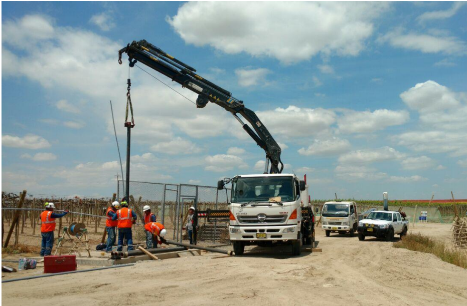
Figura 3: Pozo como fuente de abastecimiento subterráneo
