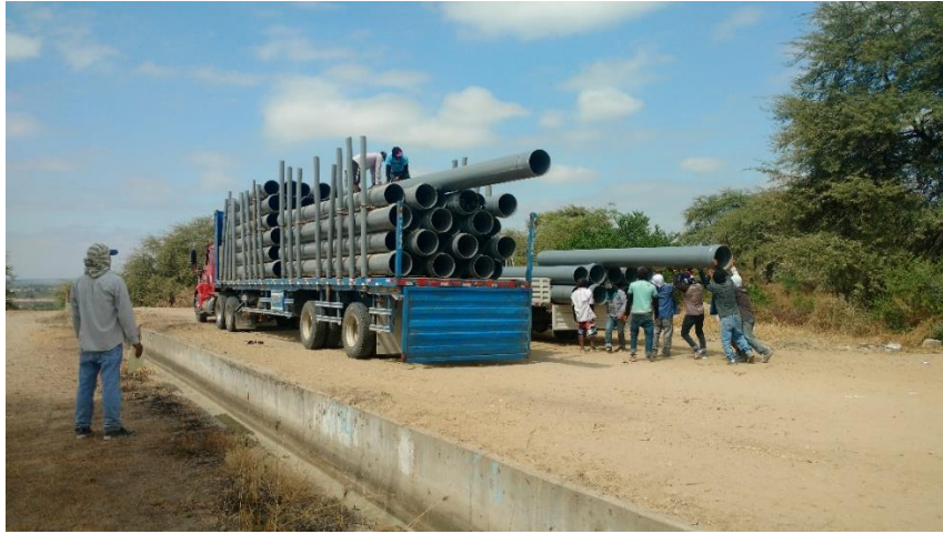
Figura 41: Descarga de tubería en proyecto Proyecto 9727 Rapel Sifón 12 (2017)
