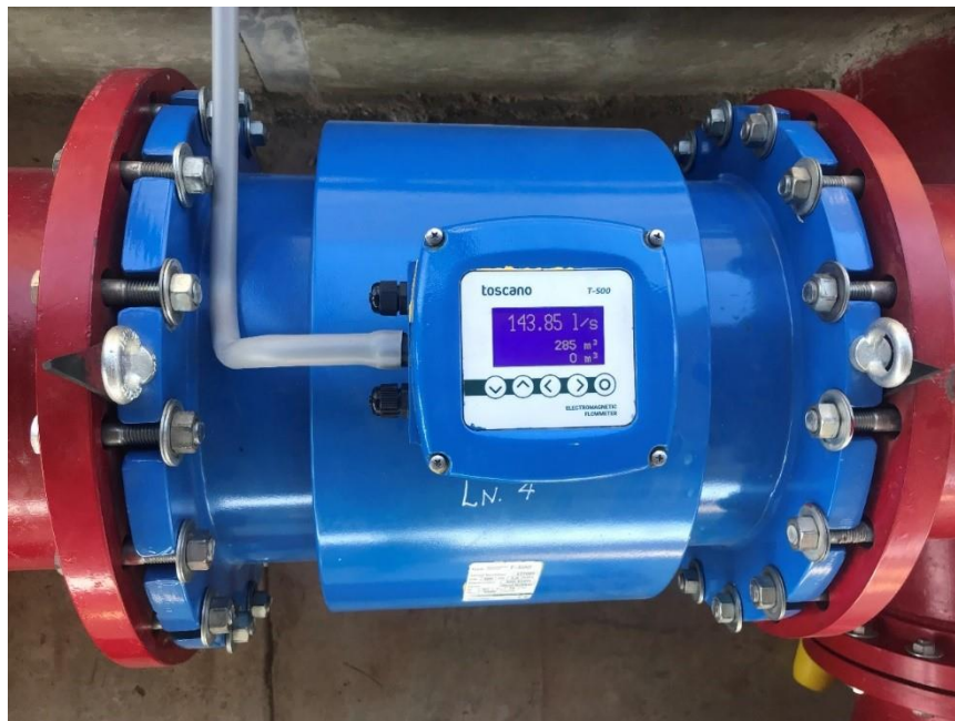
Figura 17: Medidor de caudal electromagnético de 16" (400 mm)
