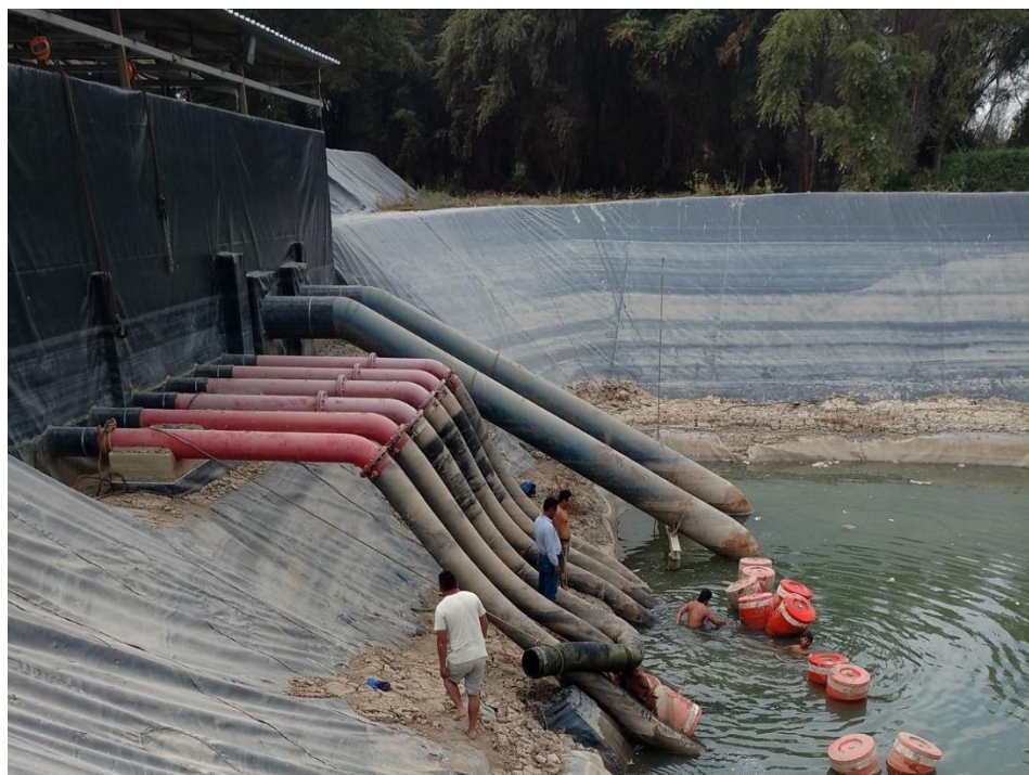
Figura 4: Obra de captación durante trabajos de mantenimiento preventivo Proyecto 9704 Labarry Operativo (2017)
