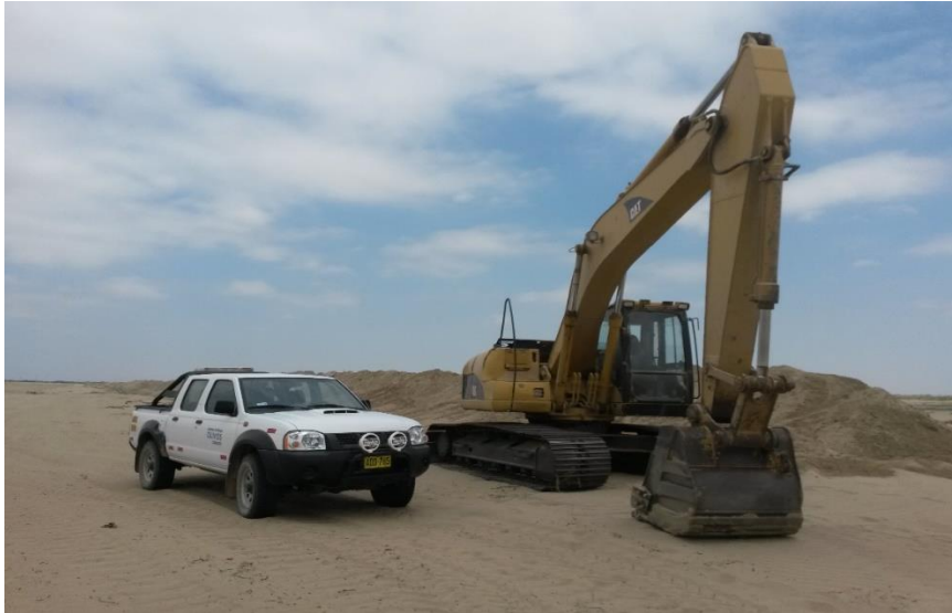
Figura 40: Revisión del estado de maquinaria para excavación Proyecto 9502 AiB Olmos (2015)
