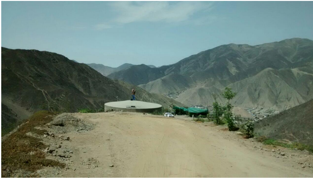
Figura 22: Tanque de agua del Campo Santo de la Comunidad Campesina Collanac
