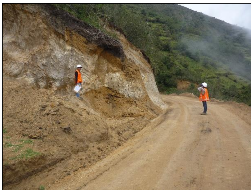
Figura 9. Verificación de la afectación por ampliación de vía - Comunidad Campesina de Quishuar.
