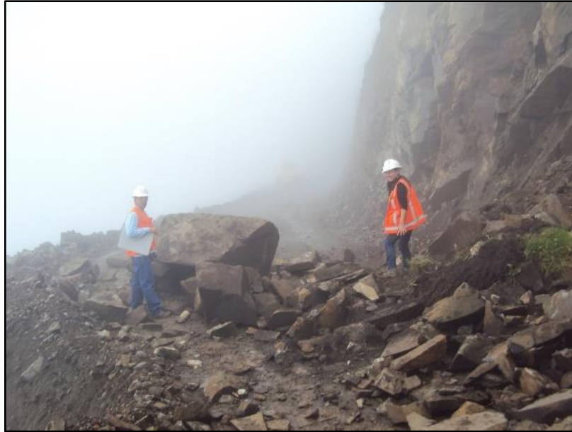
Figura 11. Deslizamiento en las áreas de trabajo en la zona Frente de Construcción.
