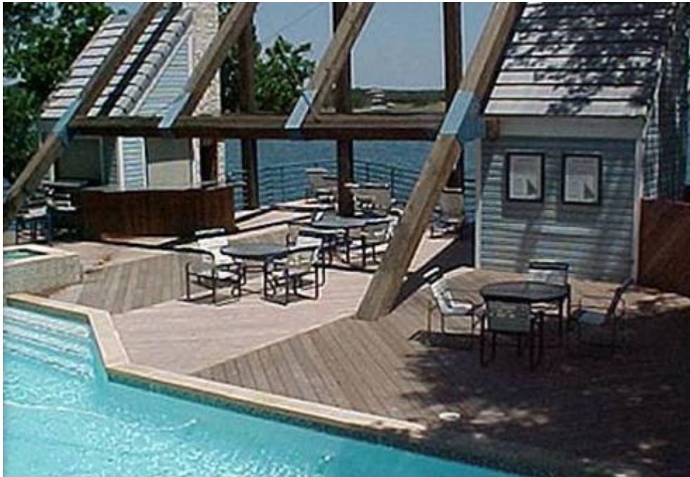
Fotos 7 y 8. Decks de Cumaru o Shihuahuaco ya instalados
