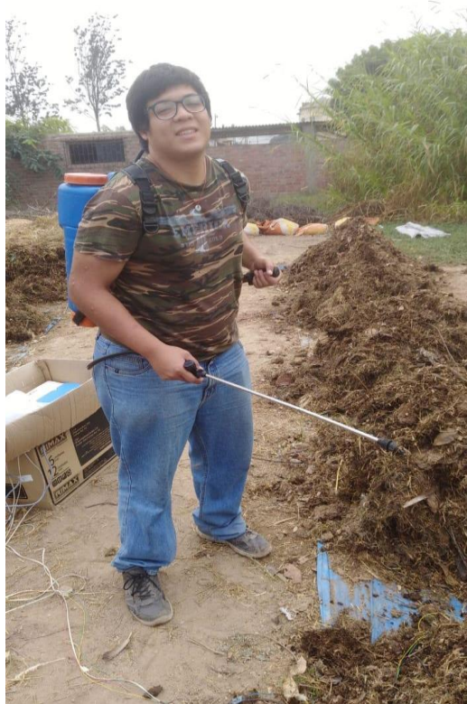
Figura 17: Inoculación de Biopilas
