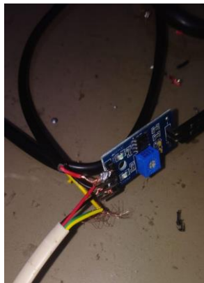
Figura 12: Instalación de termistor DS18B20
