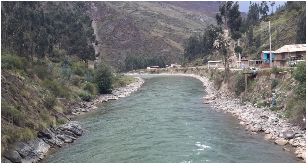
Figura 42: Vista fotográfica aguas abajo de la ubicación del puente existente Tingo Chico
