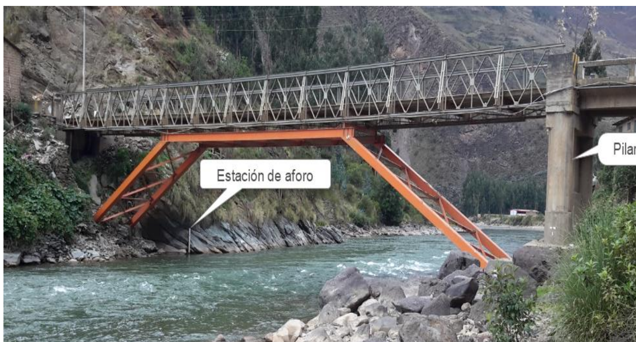
Figura 34: Vista fotográfica del puente existente Tingo Chico
