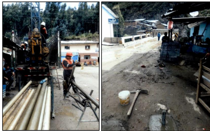
Figura 154: Vista panorámica de la perforación en el estribo Derecho
