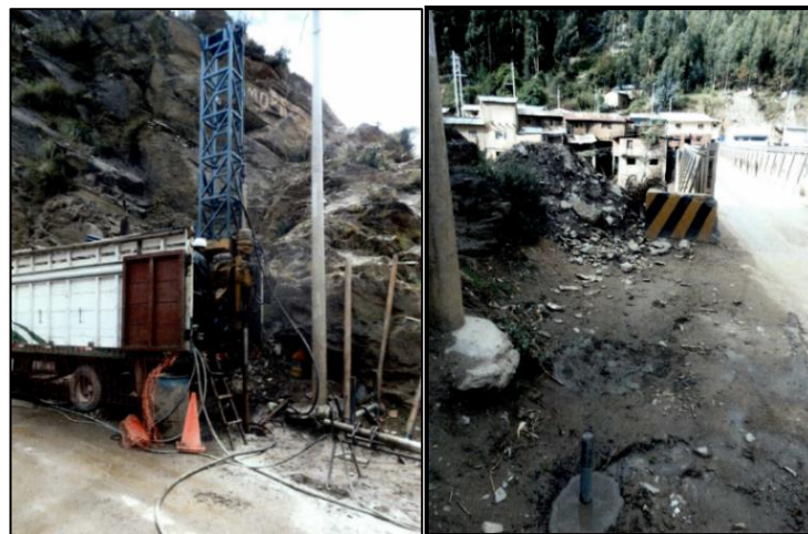
Figura 153: Vista panorámica de la perforación en el estribo Izquierdo
