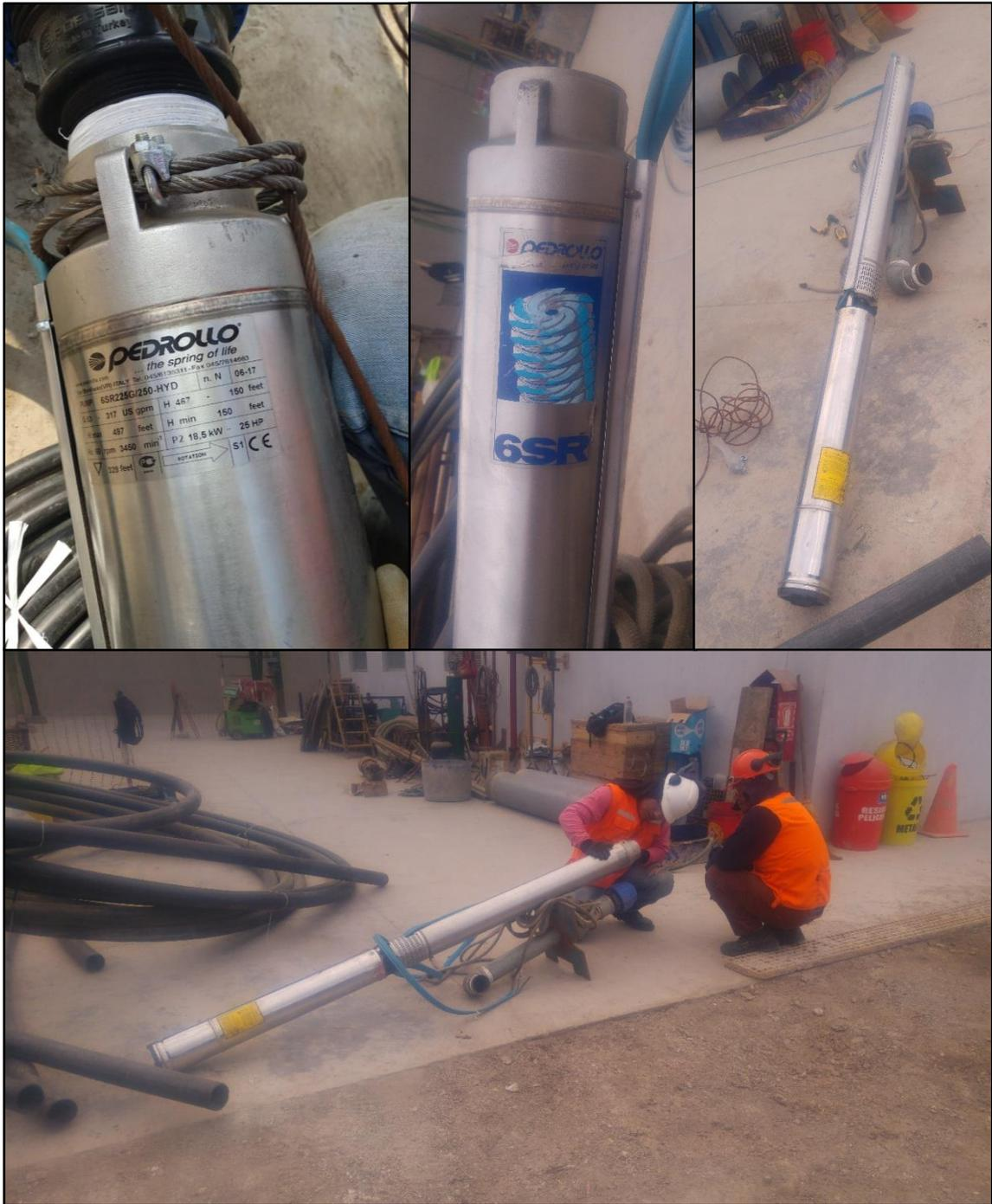
**Figura 37: Electrobomba sumergible PEDROLLO (25 HP/18.50 KW)**
