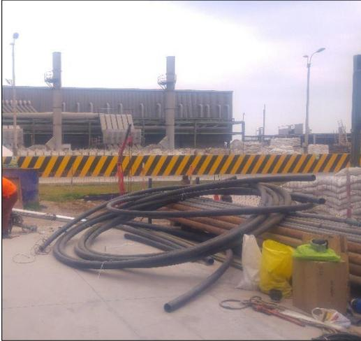
**Figura 11: Tubería de PVC de alta densidad de 3" de diámetro**
