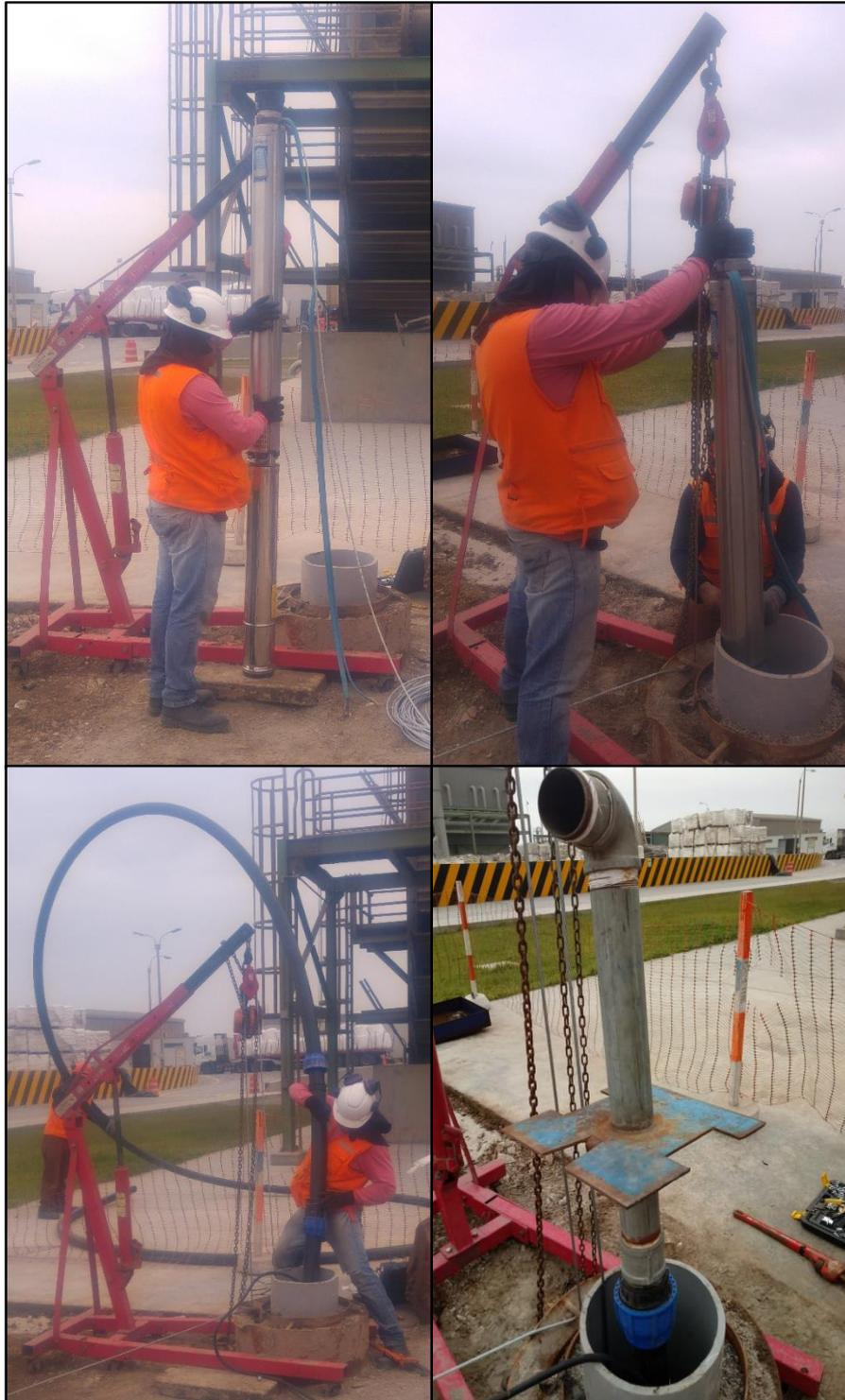
**Figura 38: Instalación de la columna de extracción**
