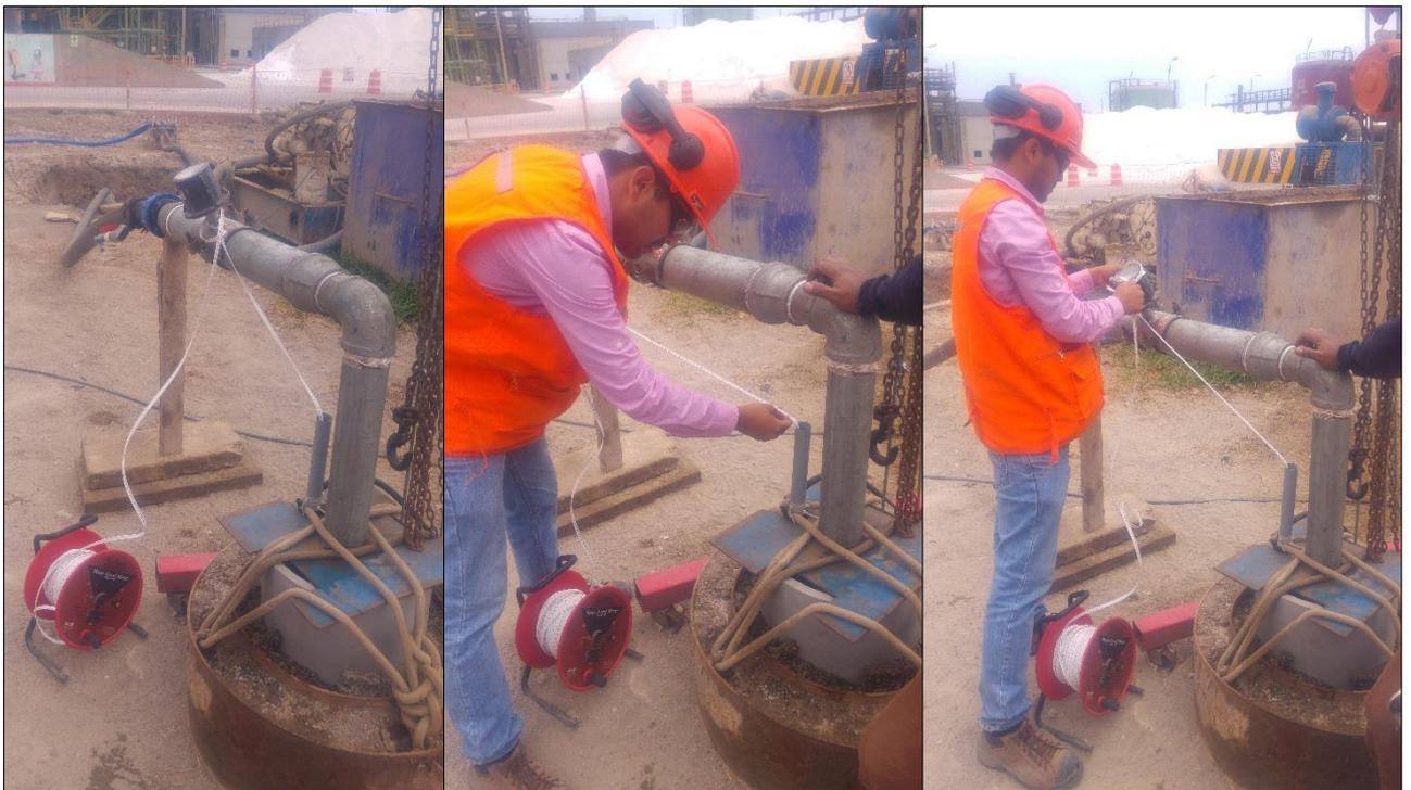
**Figura 42: Monitoreo de los niveles dinámico en el pozo QR-05A**
