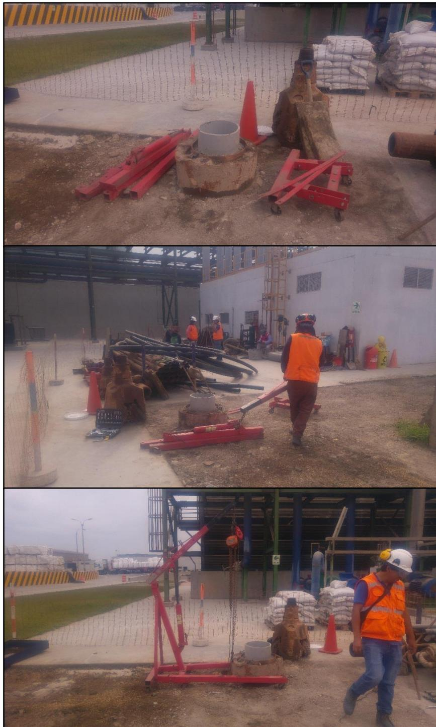
**Figura 36: Instalación del equipo de izaje (gata hidráulica)**
