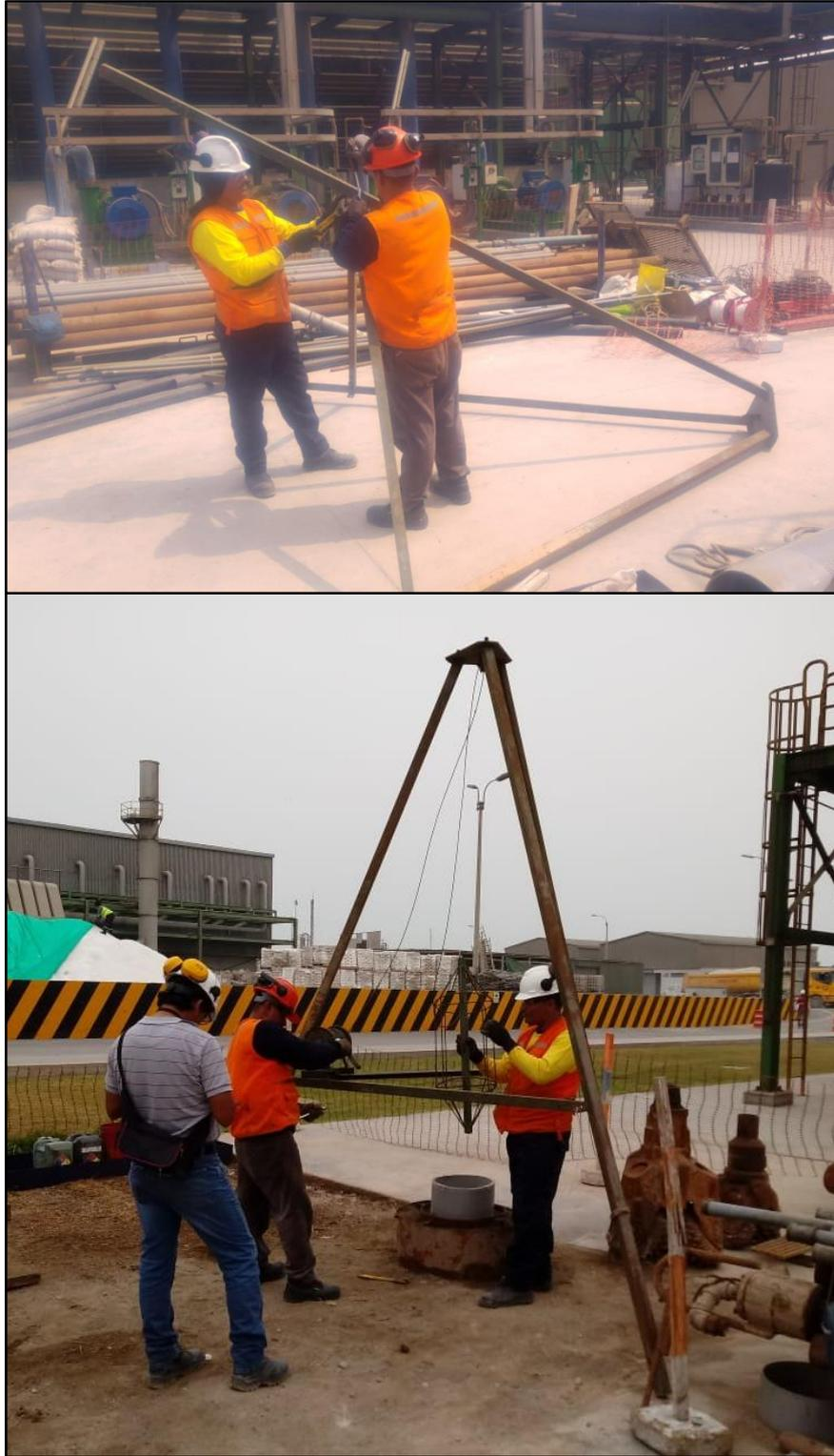
**Figura 44: Instalación del trípede (prueba de verticalidad)**
