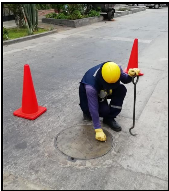
Figura N° 14: Identificación de Buzones
