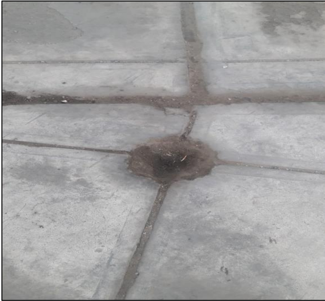
Figura N° 23: Vista del BM destruido con código BVP-8 ubicado en El Callao
