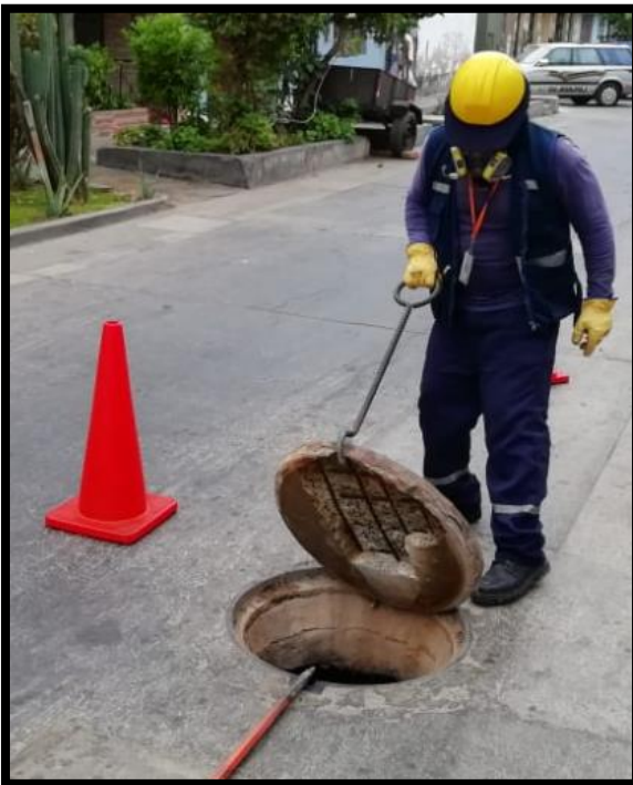
Figura N° 17: Apertura de Buzones
