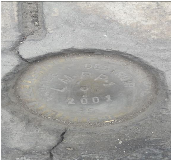
Figura N° 24: Vista del BM con código LMPP-1(La Molina)
