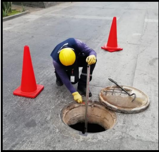
Figura N° 18: Medición de la Profundidad
