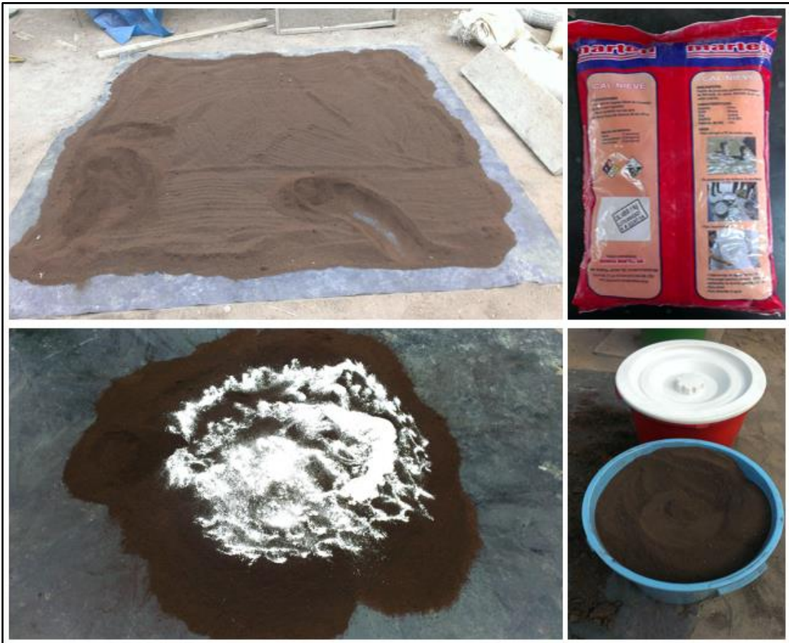
Figura 1-21 Encalado del suelo.
