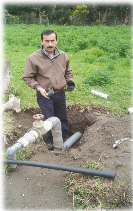
Instalación de riego
