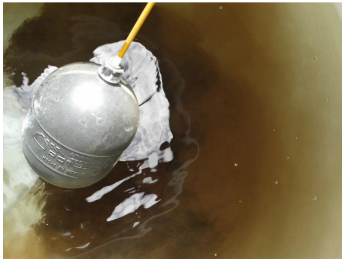
Figura 21: Tanque de almacenamiento de agua domiciliario, previo al proceso de limpieza y desinfección
