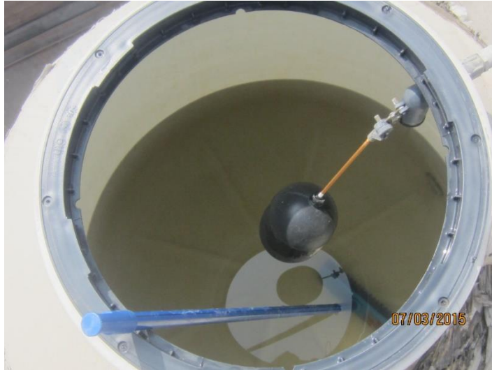
Figura 20: Tanque de almacenamiento de agua domiciliario, previo al proceso de limpieza y desinfección
