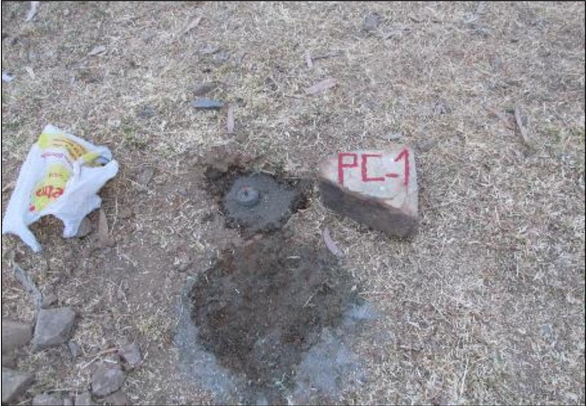
**Figura 11: Monumentación de los puntos de control colocados a lo largo del canal**
