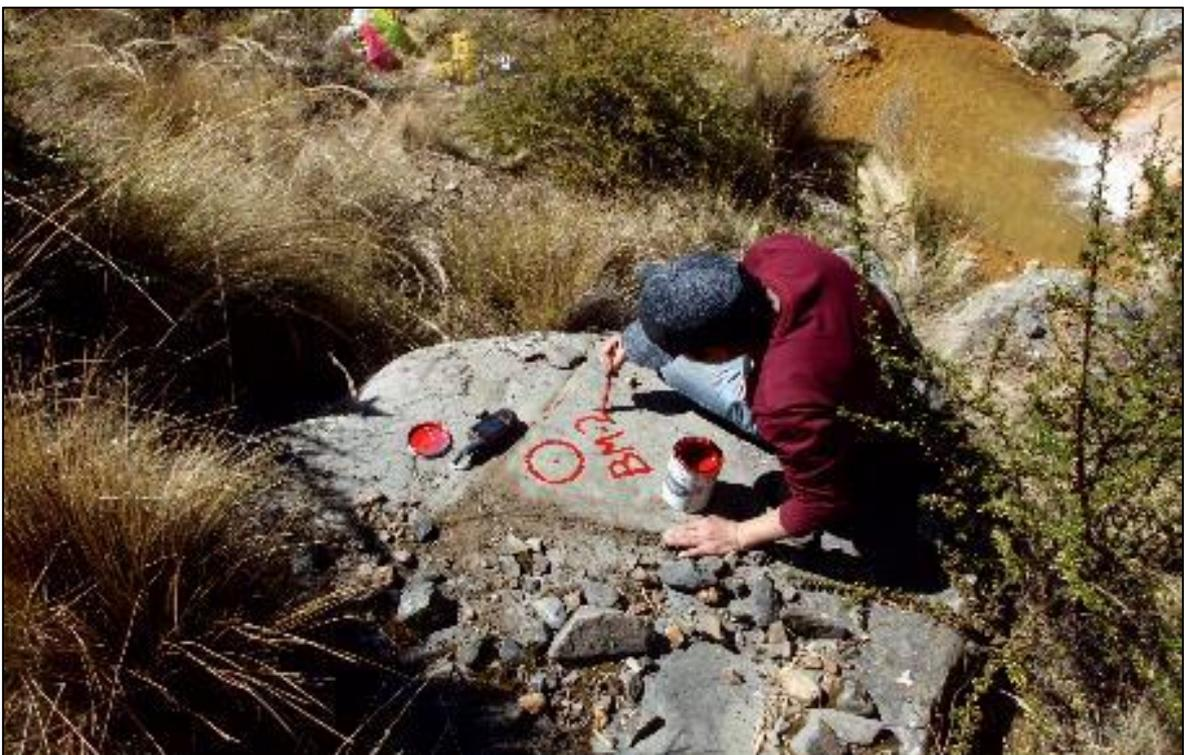
**Figura 10: Colocación de Benchmarks (BMs) pintados en rocas fijas**
