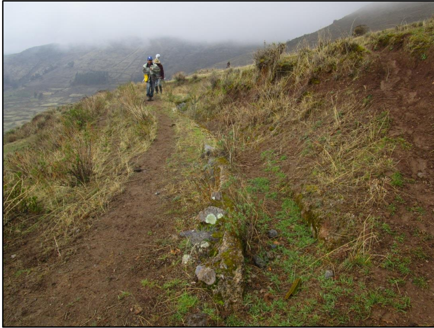
Figura 17: Vista del final del canal construido Utcas a la altura de la progresiva km 3+128
