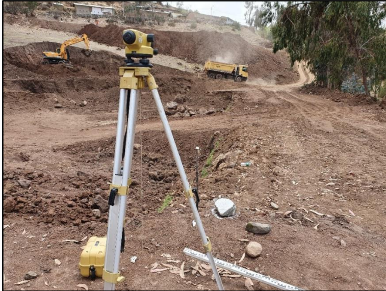
Figura 58: Nivelación en la excavación para el reservorio de Utcas
