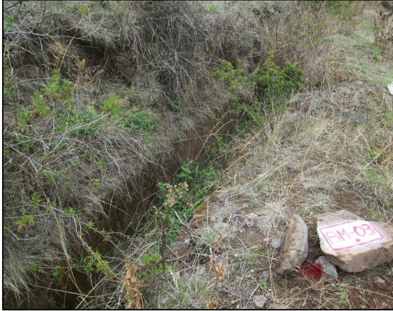
Figura 15: Vista del canal Utcas a la altura de la progresiva km 2+000
