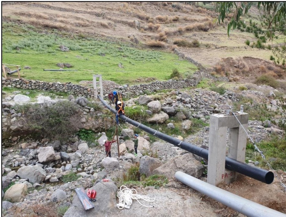
Figura 83: Instalación de tubería HDPE de 250mm para el pase aéreo del canal Pisacwain
