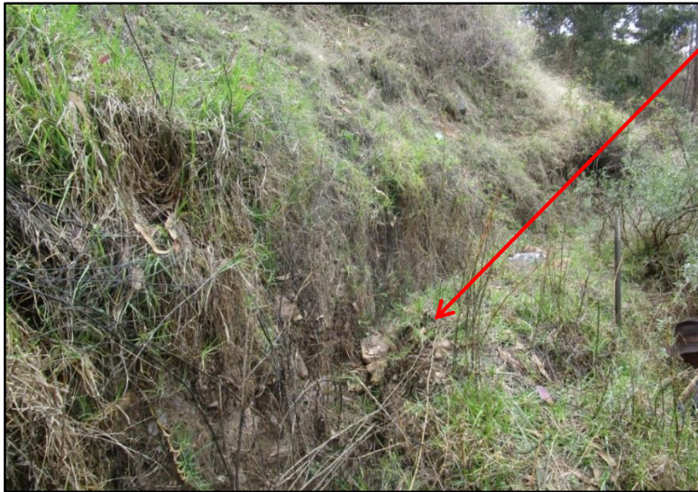
Figura 11: Vista del canal Pisacwain a la altura de la Progresiva km 0+050.
