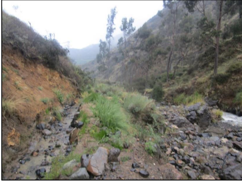
Figura 5: Vista del canal Pusgoj a la altura de la Progresiva km 0+000.
