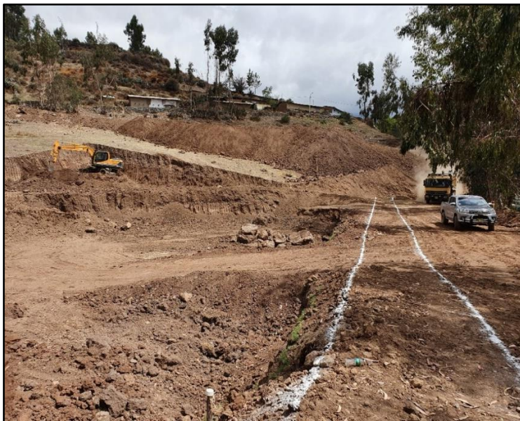
Figura 59: Replanteo para la excavación del reservorio de Utcas
