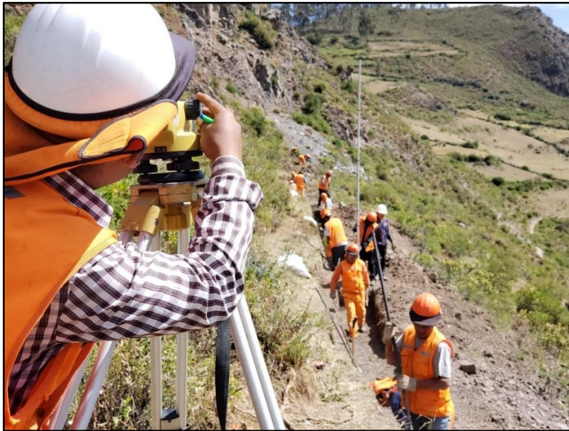
Figura 71: Nivelación de fondo de excavación en el canal Utcas
