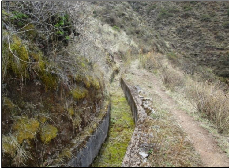
Figura 16: Vista del canal Utcas a la altura de la progresiva km 2+200
