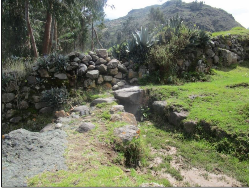
Figura 12: Vista del canal Pisacwain a la altura de la Progresiva km 0+300.
