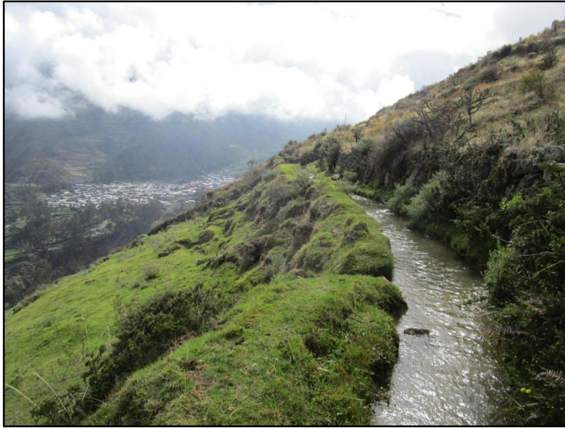
Figura 8: Vista del canal Pusgoj a la altura de la Progresiva km 4+000.
