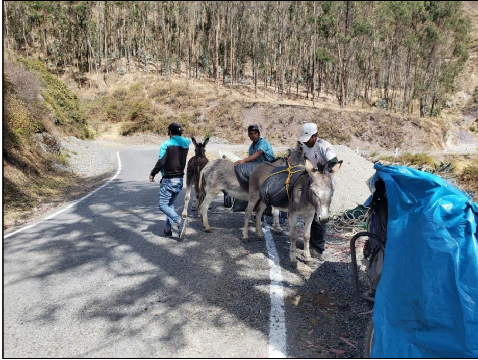
Figura 78: Carguío de hormigón con acémilas para el canal Utcas
