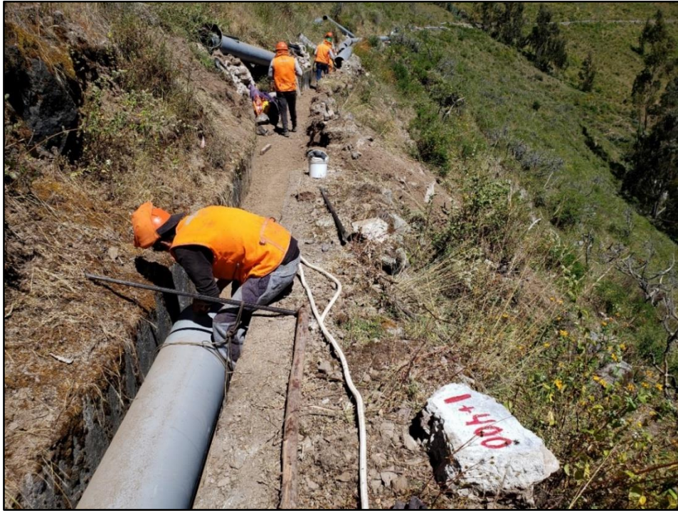
Figura 49: Instalación de las tuberías PVC de 400mm en el canal Utcas
