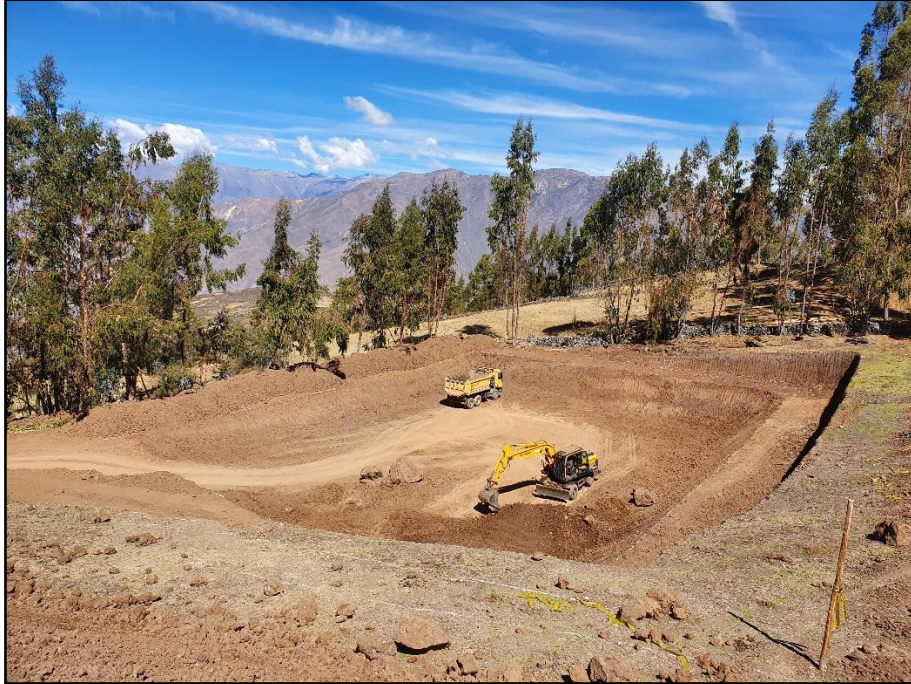
Figura 60: Maquinaria en la excavación del reservorio de Utcas
