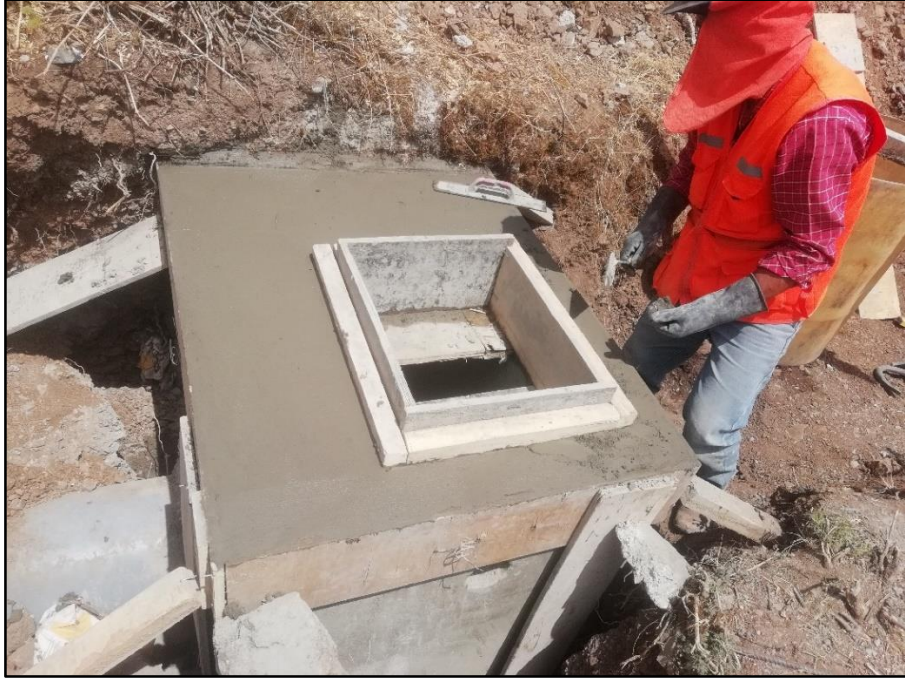
Figura 69: Solaqueado y remate en techo de caja de inspección del canal Utcas
