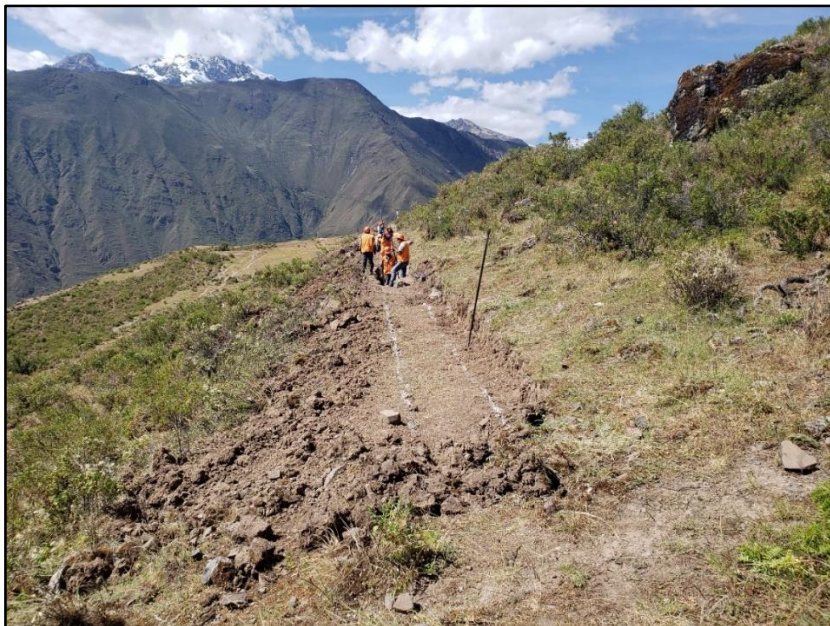
Figura 72: Replanteo del eje del canal Utcas
