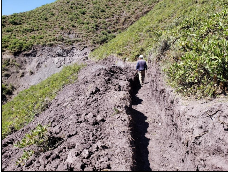
Figura 73: Vista de la caja de canal excavado en el canal Utcas
