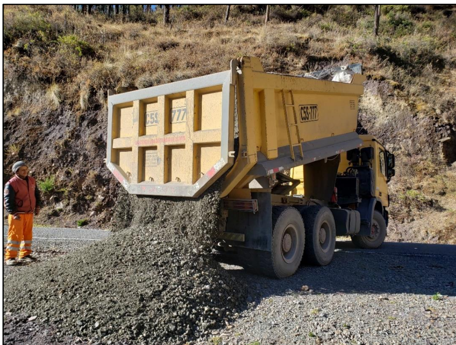
Figura 77: Descarga de hormigón para las obras de arte del Canal Utcas
