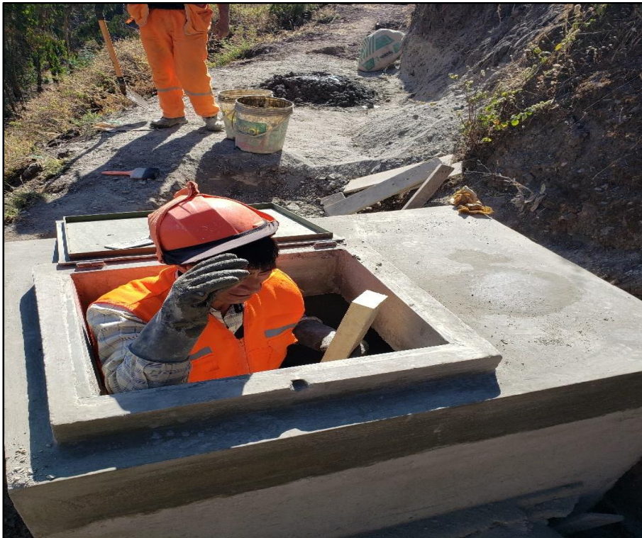
Figura 70: Caja de inspección terminada en el canal Utcas
