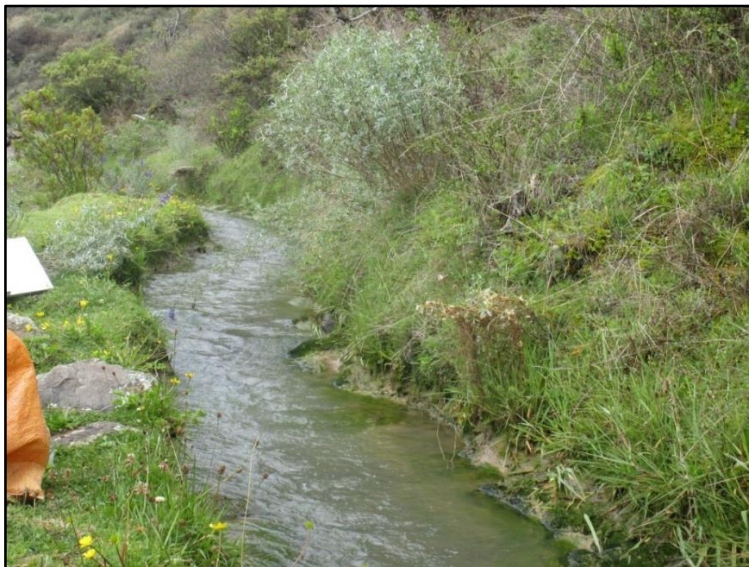
Figura 7: Vista del canal Pusgoj a la altura de la Progresiva km 1+500.
