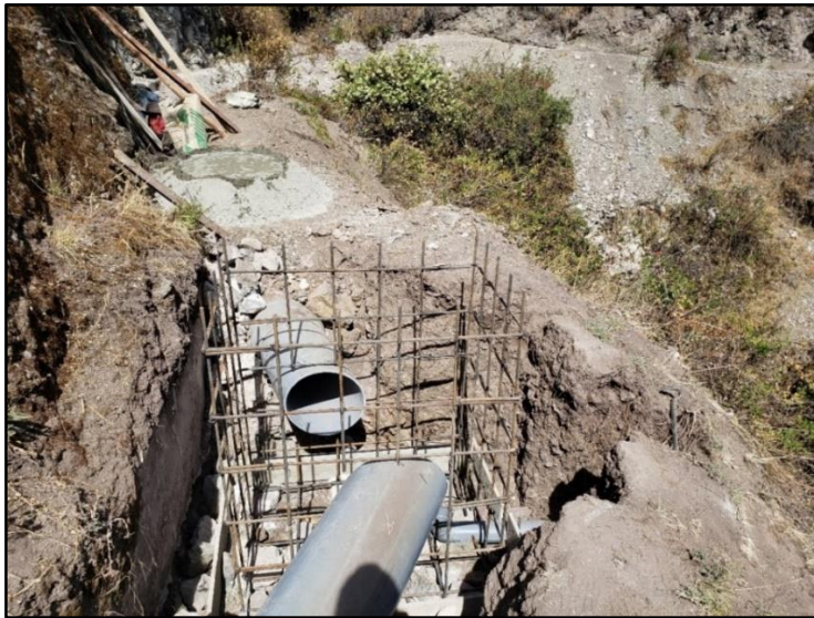
Figura 65: Caja de inspección en el canal Utcas
