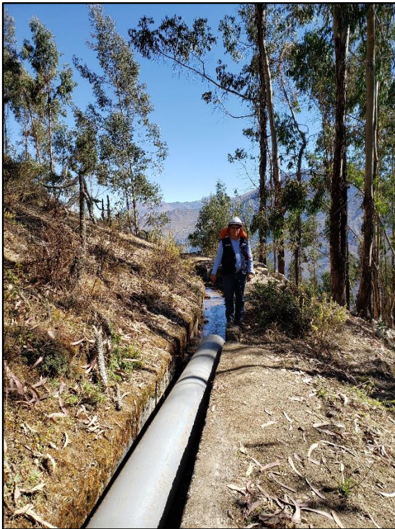
Figura 85: Instalación de la tubería PVC de 400mm en el canal Utcas
