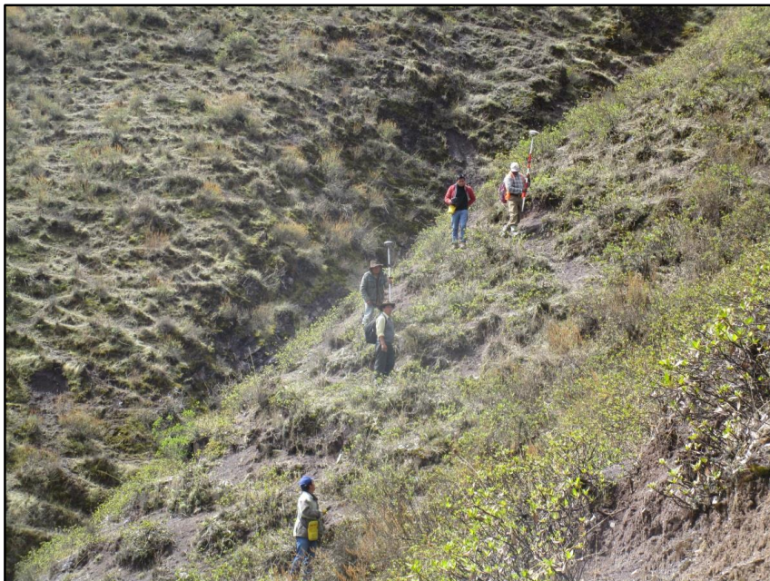
Figura 18: Vista del levantamiento topográfico para el trazo del canal Utcas a la altura de la progresiva km 5+000
