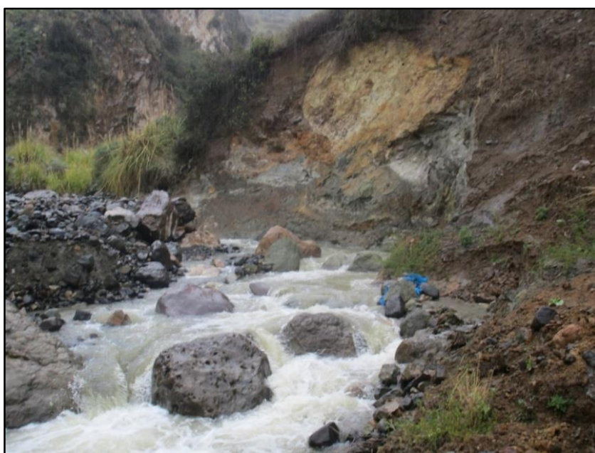
Figura 4: Vista de la toma de captación del canal Pusgoj.
