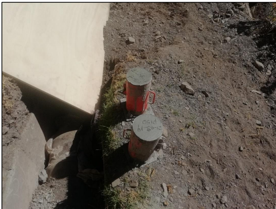
Figura 76: Vista de probetas tomadas de cámaras de inspección
