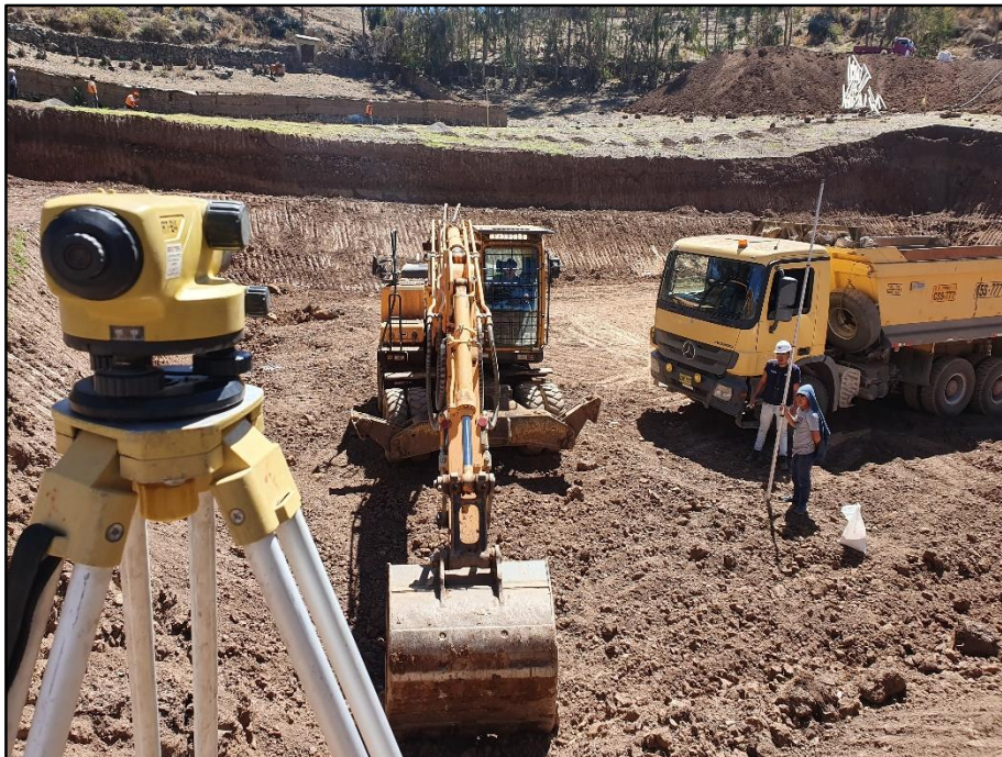
Figura 61: Maquinaria en la excavación del reservorio de Utcas
