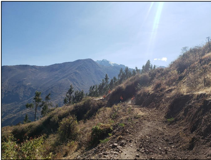
Figura 87: Relleno final para la tubería PVC de 400mm en el canal Utcas
