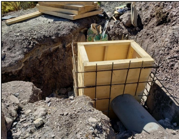
Figura 66: Encofrado de caja de inspección en el canal Utcas
