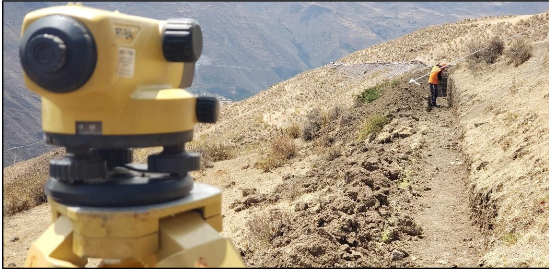
Figura 51: Nivelación de fondo de excavación en el canal Utcas
