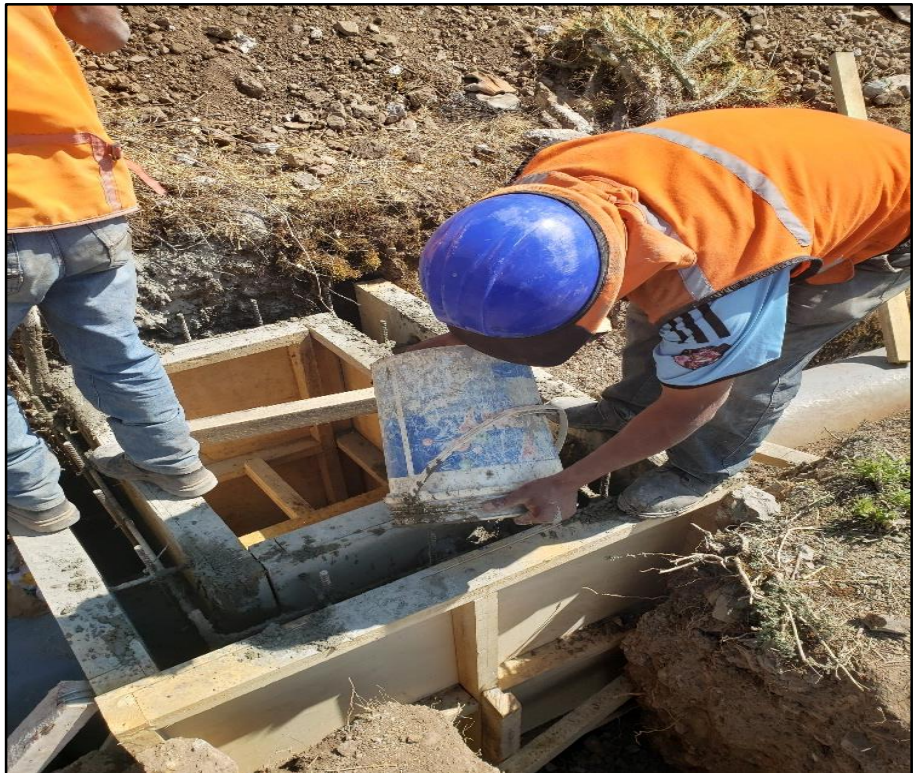
Figura 68: Vaciado de concreto en la caja de inspección del canal Utcas
