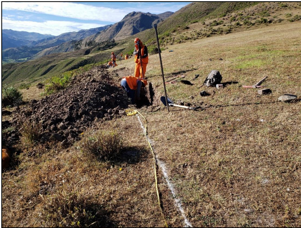
Figura 52: Replanteo del eje del canal Utcas
