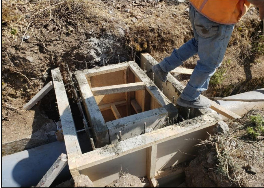
Figura 67: Encofrado de caja de inspección en el canal Utcas
