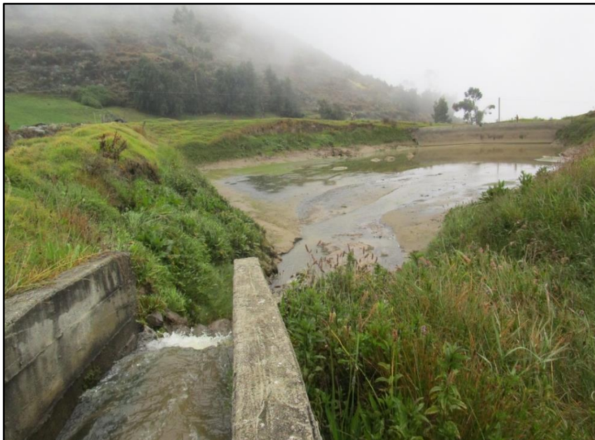
Figura 9: Canal de descarga al reservorio Pusgoj
