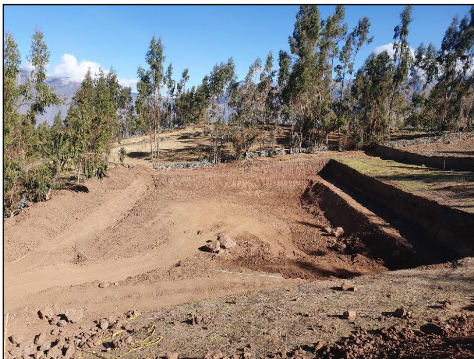
Figura 75: Vista del reservorio de Utcas
