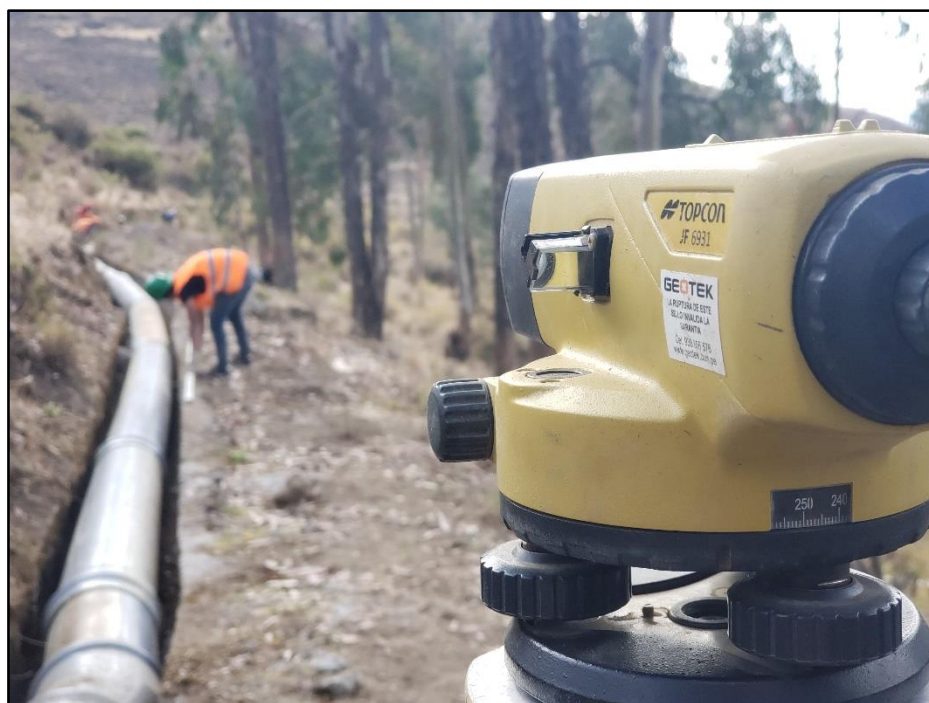
Figura 47: Vista de colocado de BMs en el canal Utcas a la altura de la progresiva 3+200
