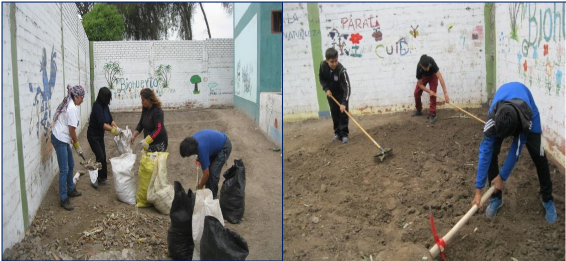
Figura 22: Limpieza y remoción del terreno.
