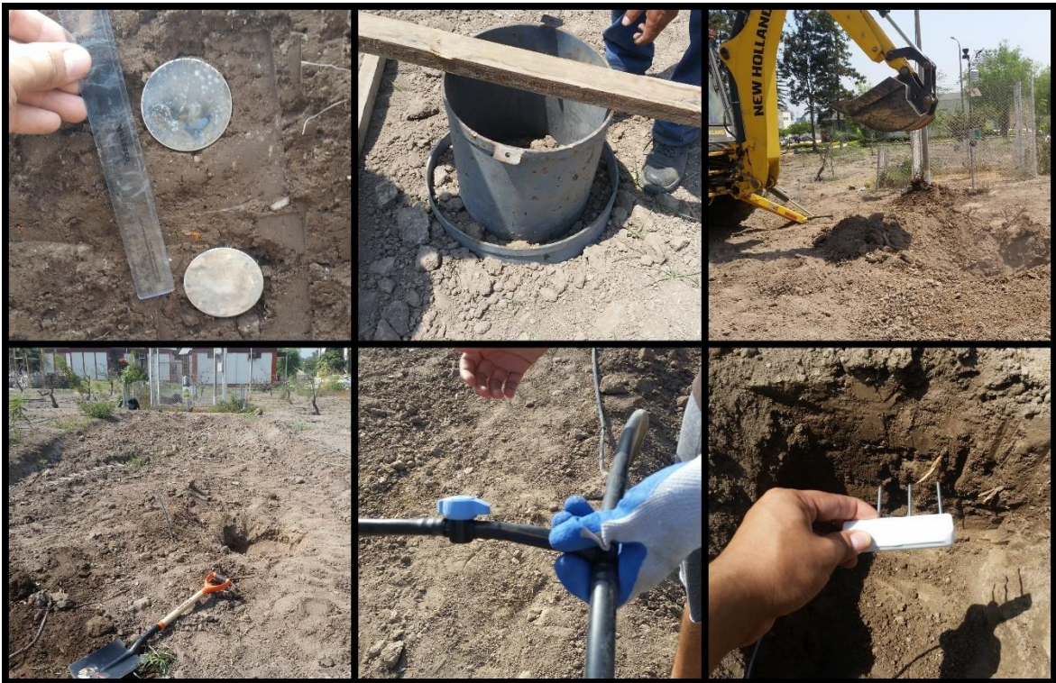
Figura 70: Preparación del terreno
