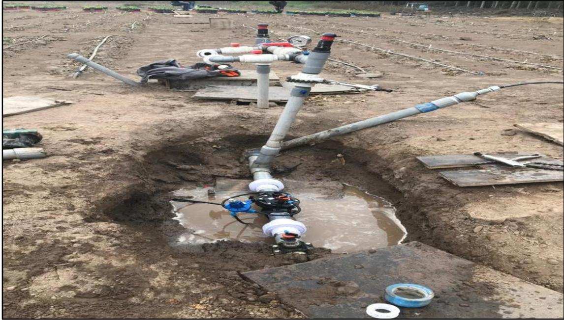
**Instalación de válvula reguladora de presiones**
