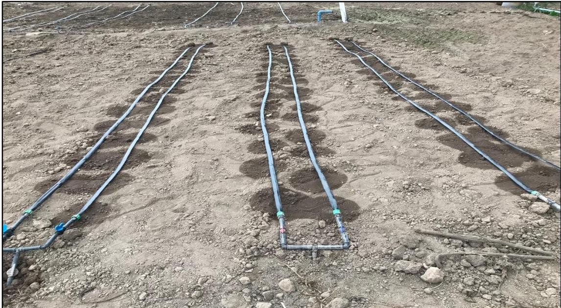
**Prueba de funcionamiento del sistema de riego**
