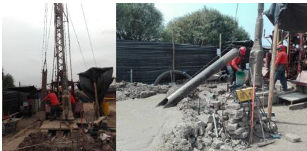
Figura 11: Limpieza del pozo
