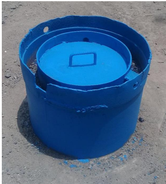
Figura 23: Vista del sello sanitario culminado y del anillo engravador
