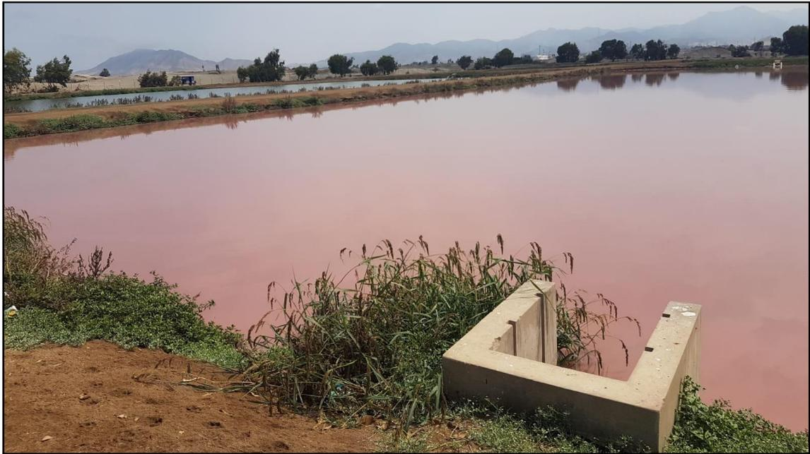
***Figura 66: Laguna de oxidación en mal estado***
