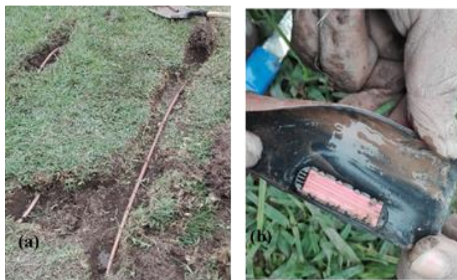
Figura 47: a) Excavación de laterales enterrados b) Inspección de los goteros enterrados del tratamiento 0,4 ETo, no presenta invasión de raíces.
