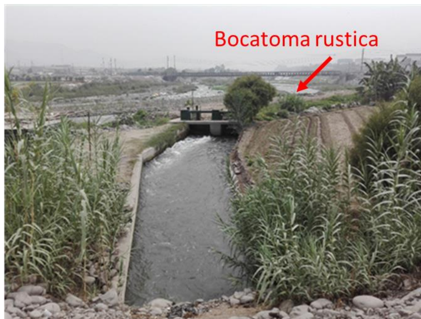
Figura 66: Bocatoma rustica, sector Vitarte.
