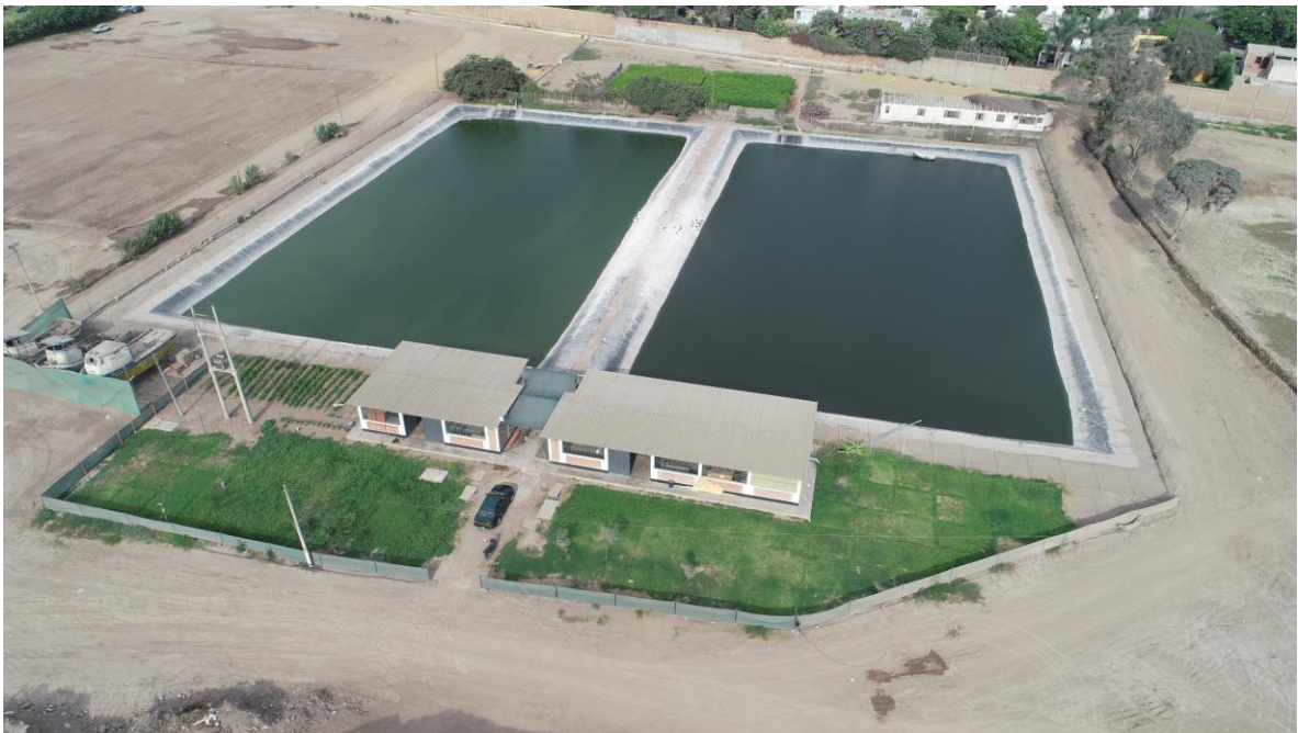
Figura 32: Casetas y reservorio, fotos tomadas desde un dron.
