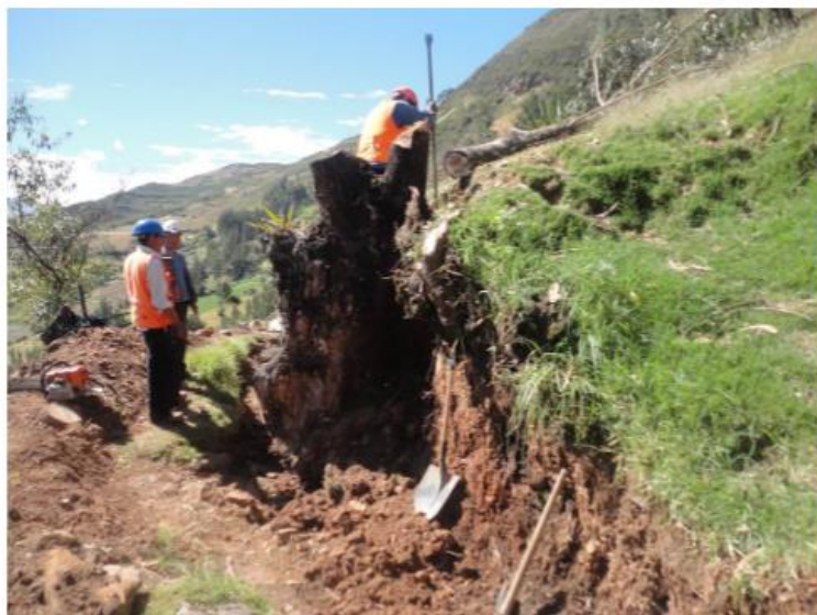
Figura 24. Limpieza de terreno en la línea de conducción
