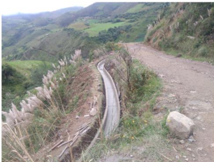
Figura 28. Vista de tramo de canal vaciado
