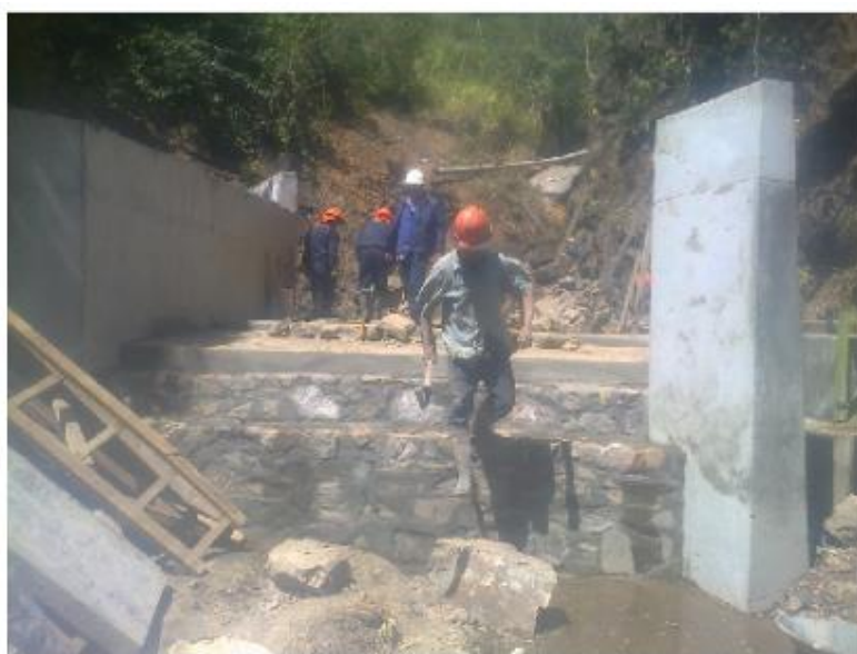
Figura 63. Trabajos de mampostería de piedra emboquillada en bocatoma Peña Suave
