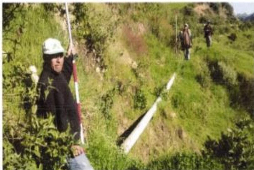
Figura 5. Km 1+755-1+766.50, se observa deslizamiento de terreno y tubería colocada provisionalmente
