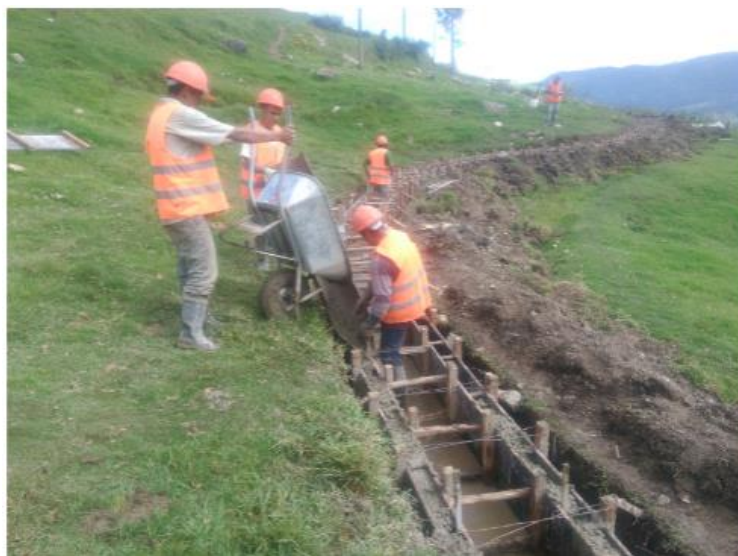
Figura 27. Trabajos de vaciado en muros del canal de conducción
