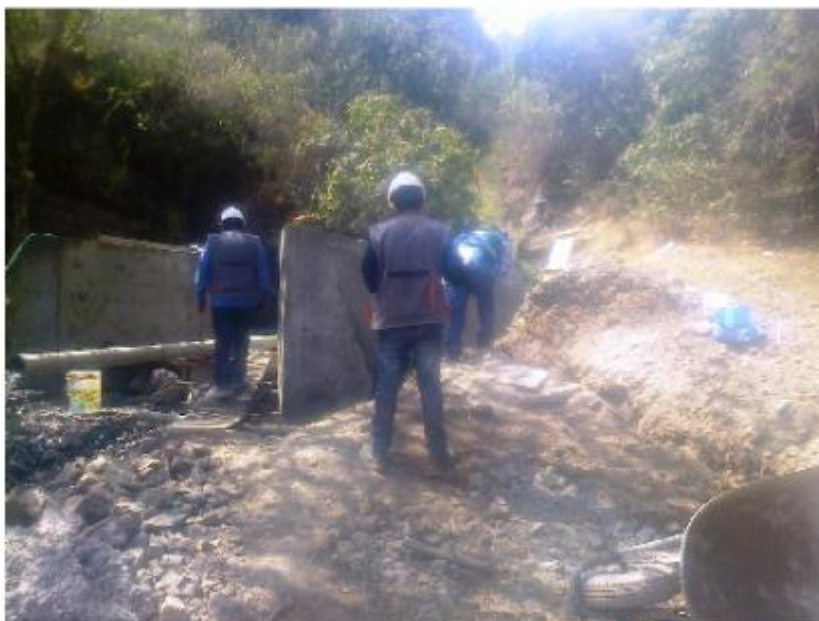
Figura 61. Trabajos de encofrado de la bocatoma Capulí
