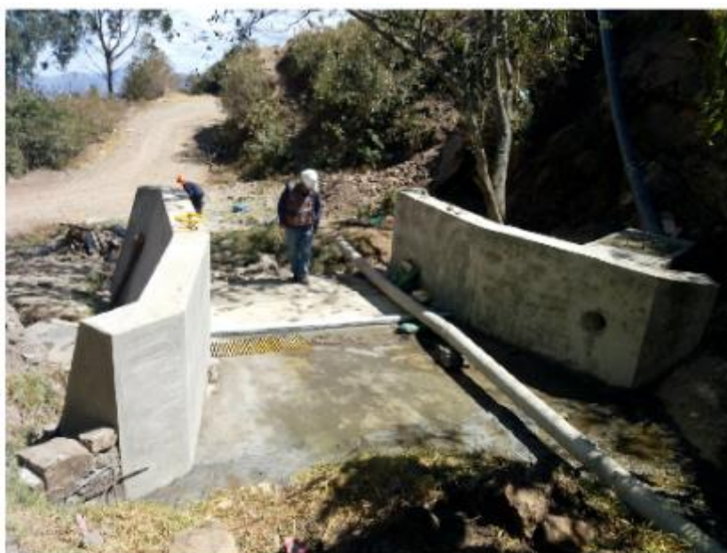
Figura 66. Trabajos realizados en bocatoma Peña Suave
