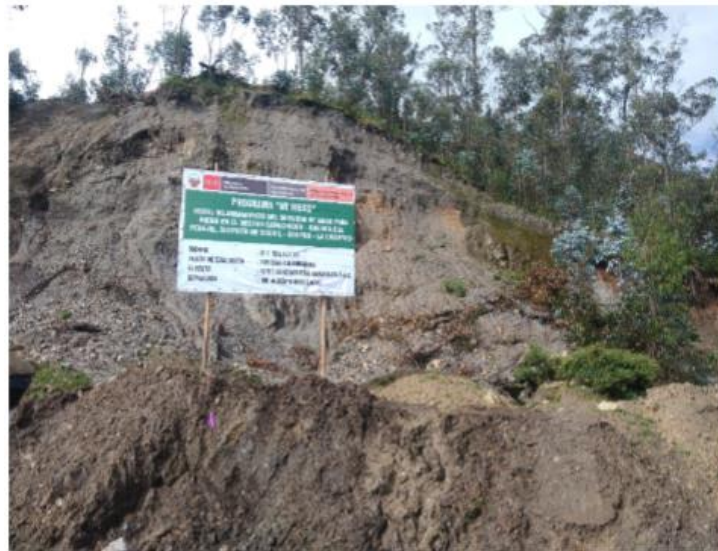
Figura 23. Vista del cartel en obra colocado en la localidad de capachique
