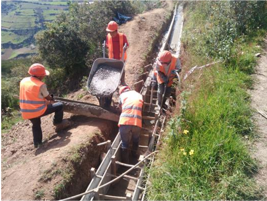
Figura 32. Vista de trabajos de encofrado de caja de canal listo para vaciado de concreto
