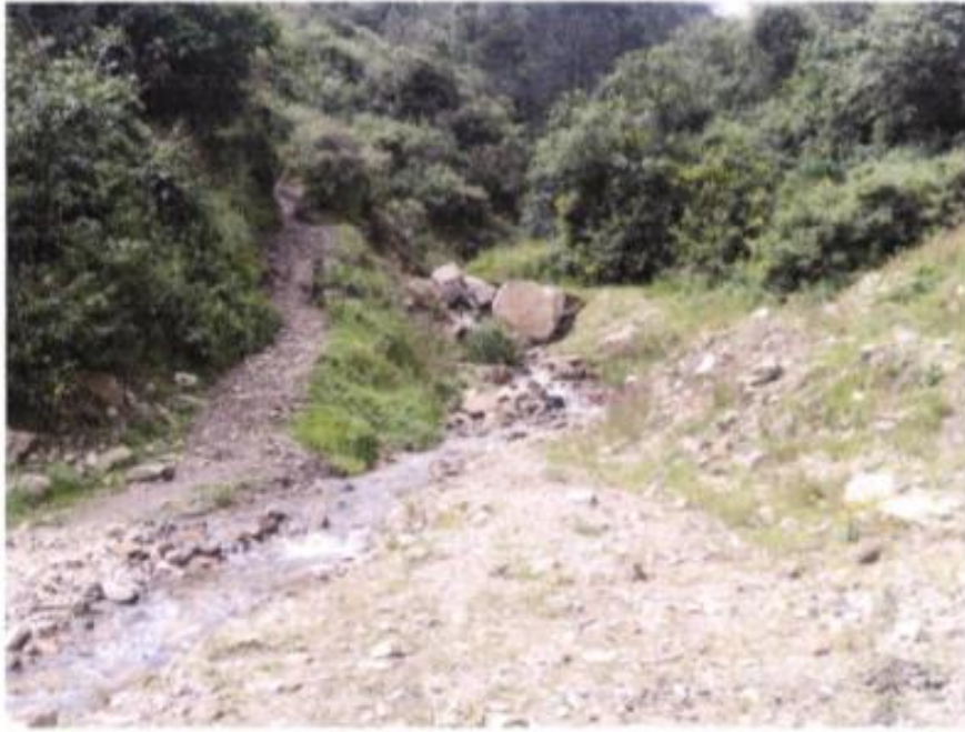
Figura 4. Vista del deslizamiento en la margen derecha donde se proyectó la captación capulí
