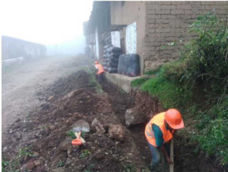
Figura 25. Excavación manual de caja de canal chacomas en material suelto
