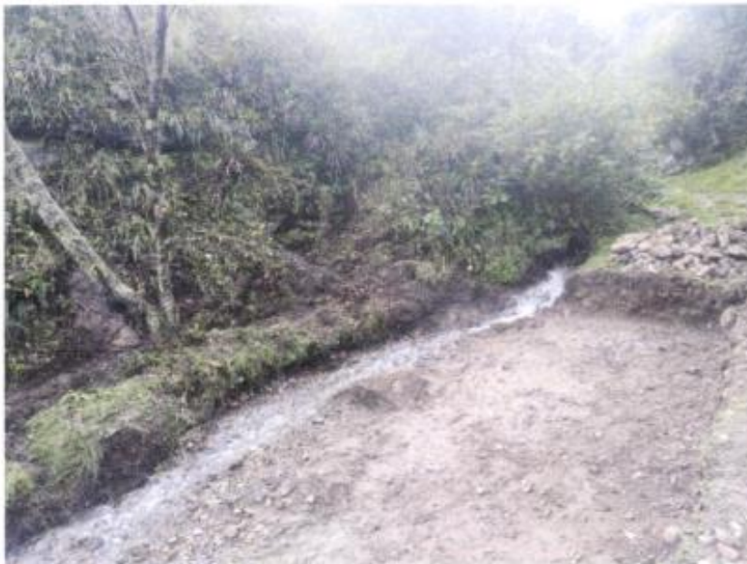
Figura 3. Vista del deslizamiento en la margen derecha donde se proyectó la captación churgues
