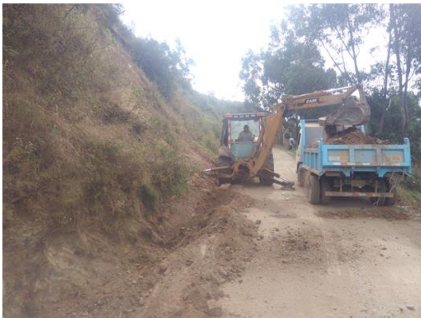
Figura 30. Vista de trabajos de excavación de caja de canal con maquinaria
