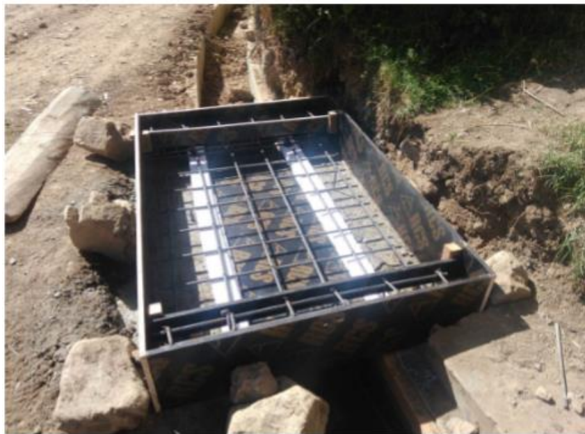
Figura 37. Vista de trabajos terminados en poza disipadora
