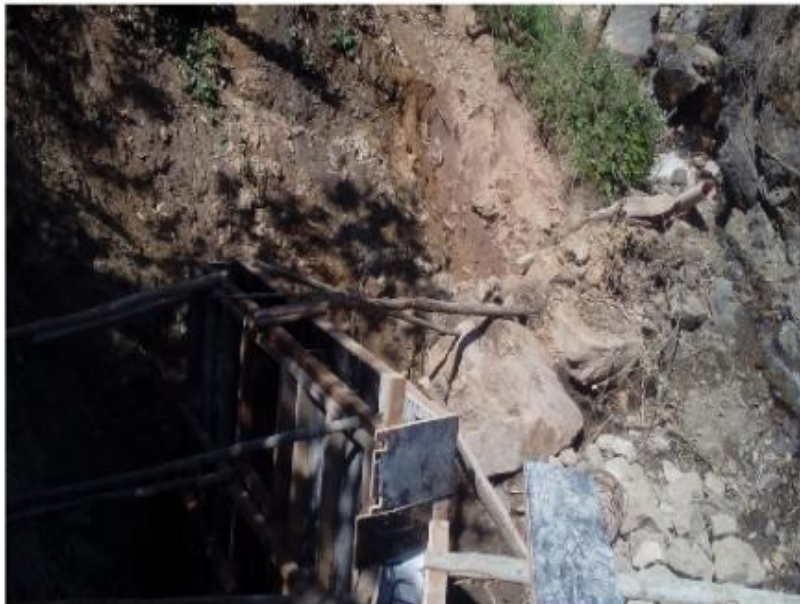
Figura 59. Trabajos de encofrado en muro de margen derecha en bocatoma surges
