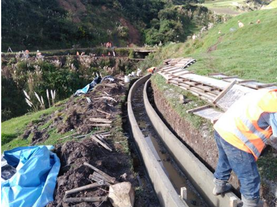
Figura 33. Tramo de canal vaciado recién desencofrado
