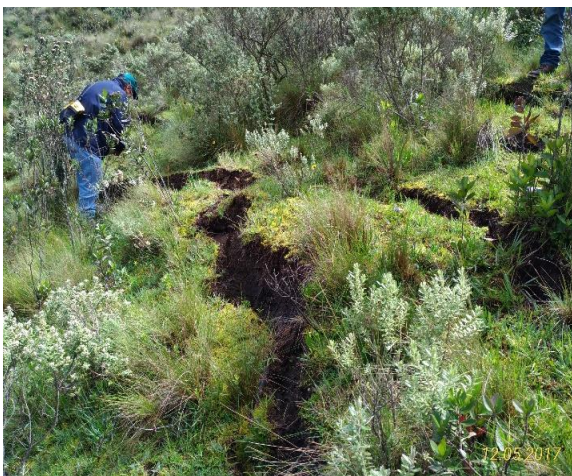
Figura 20 . Vista del terreno de la línea de conducción en tramo rocoso
