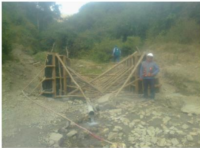
Figura 60. Trabajos de encofrado en muros de protección en bocatoma Peña Suave
