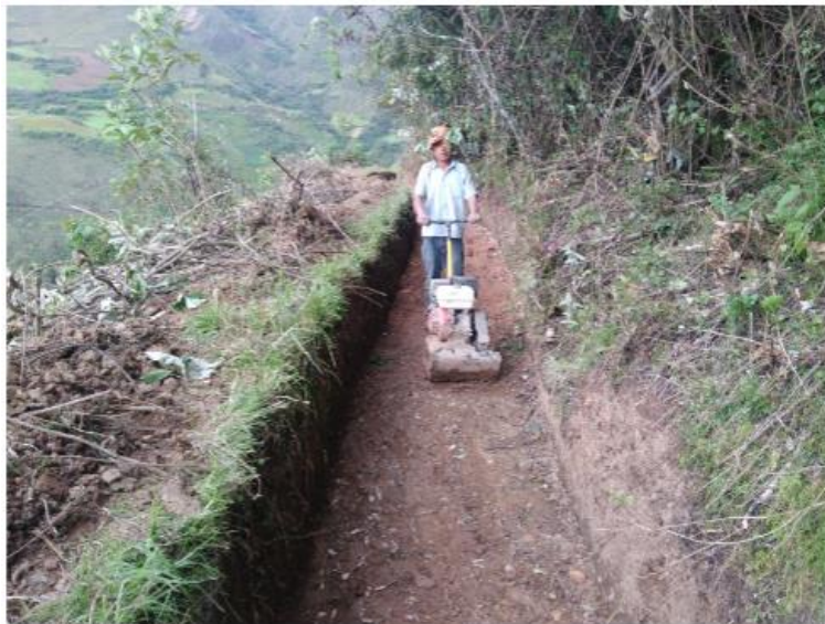
Figura 26. Trabajos de compactación en caja de canal chacomas
