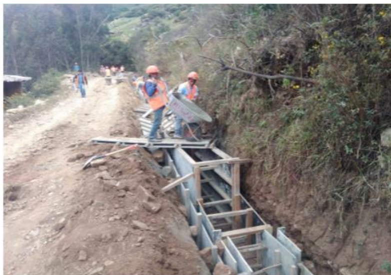
Figura 36. Trabajos de vaciado de concreto en poza disipadora
