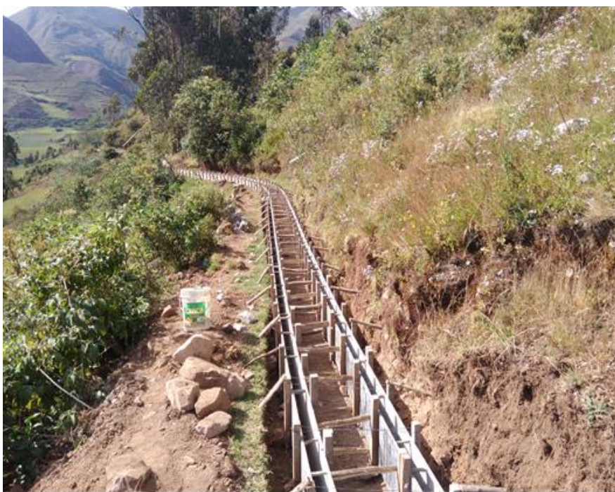
Figura 31. Vista de trabajos de encofrado de caja de canal listo para vaciado de concreto
