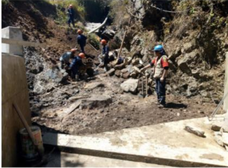
Figura 58. Trabajos de excavación en terreno rocoso en bocatoma surges
