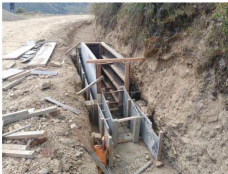
Figura 35. Vista de trabajos de encofrado en poza disipadora listo para vaciado de concreto
