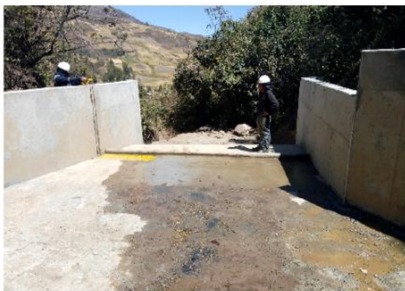
Figura 64. Trabajos realizados en bocatoma surges
