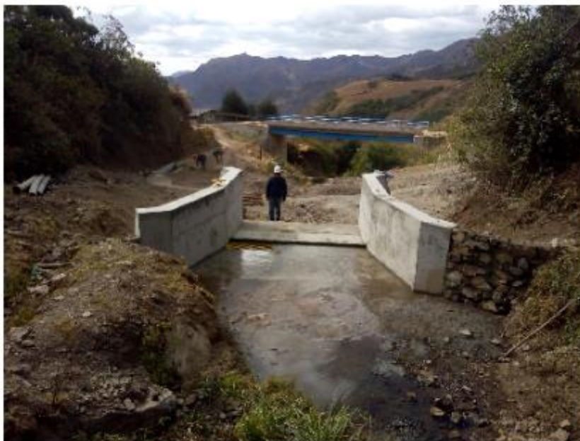
Figura 65. Trabajos realizados en bocatoma capulí
