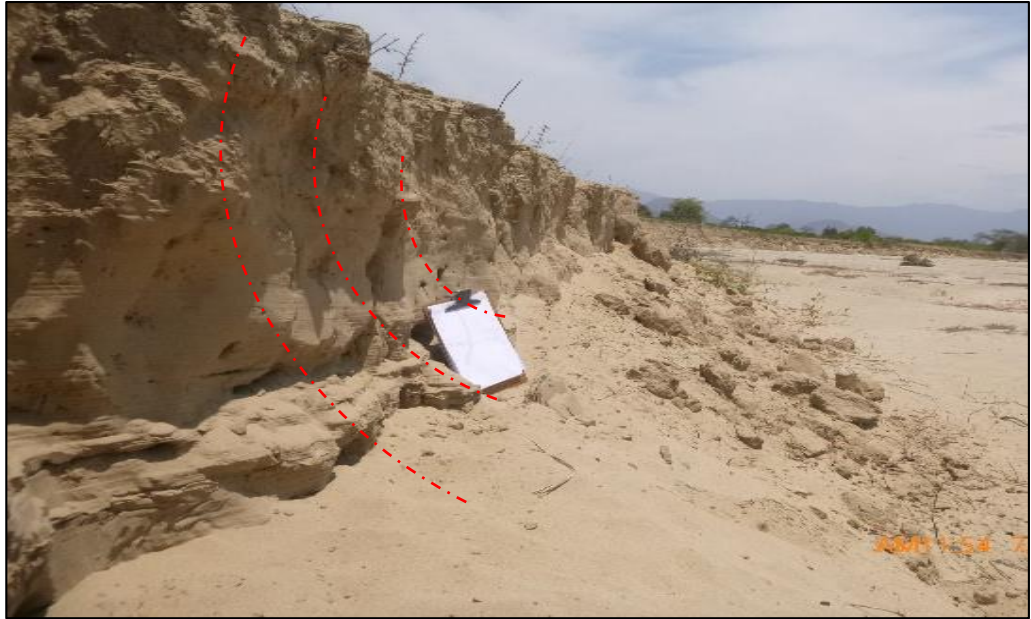
Figura 18: Socavación progresiva del margen derecho
