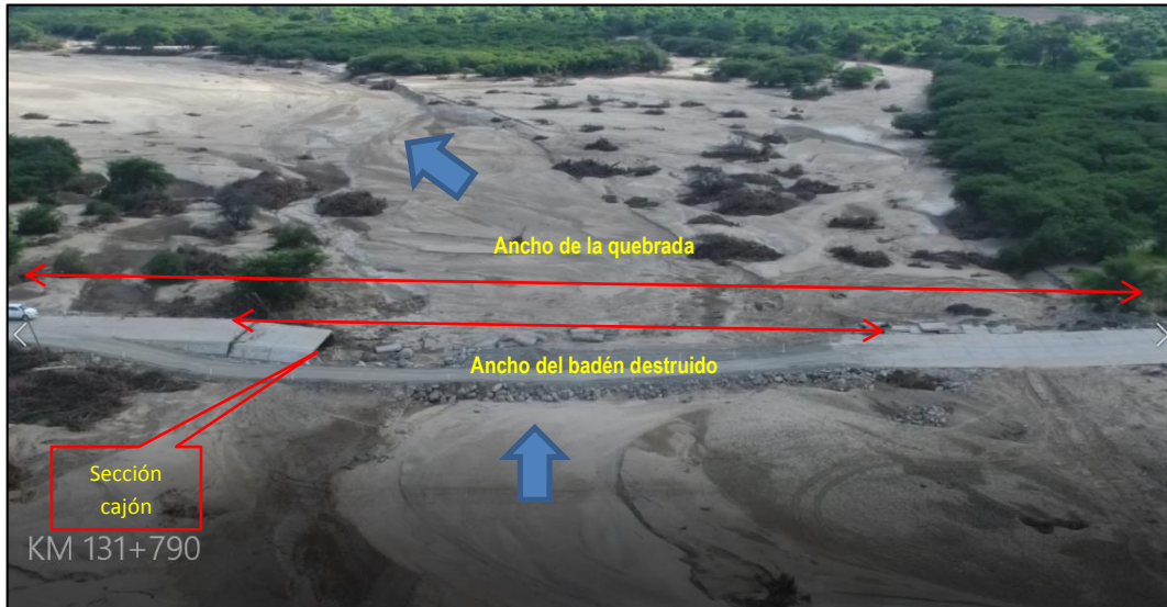
Figura 7: Cauce generado del 2017 en el badén Querpón
