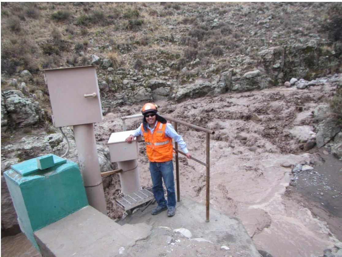
Foto 8: Inspección de Estación Hidrométrica aguas arriba de la presa en el instante de una máxima avenida.
